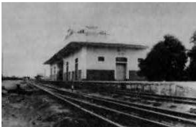
FIGURA 4 - ANTIGA ESTAÇÃO DE TREM DA CIDADE NA DÉCADA DE 1980. (Fonte: Prefeitura de Mossoró, 2005).
