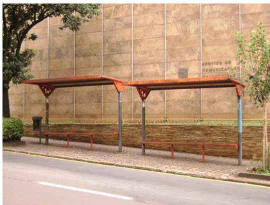
Figura 4.3 - Exemplo de ponto de ônibus na área central de Londrina
