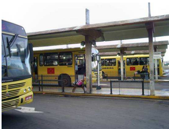
Figura 4.2 - Detalhe do terminal central de Londrina
