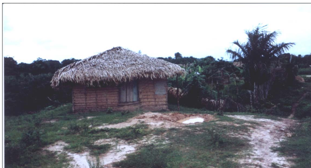
Figura 6 - Moradia observada nas áreas pesquisadas Fonte: Arquivo do autor (2005)
