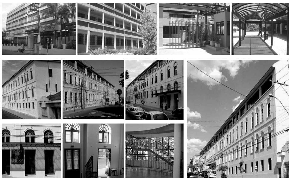
Figura 30. Campus II UNIFRA. Em 1998 o Bispo Dom Ivo Lorscheiter destinou o Educandário São Vicente de Paula ao Centro Universitário Franciscano. A reforma foi projetada pelo engenheiro civil Bruno Brondani e pelas arquitetas Tércia Kapp e Nívea da Costa proporcionando a recuperação do histórico edifício, preservando um dos maiores patrimônios arquitetônicos de Santa Maria. A estrutura interna do prédio foi totalmente remodelada e adequada às necessidades da UNIFRA, sendo a fachada original mantida. O prédio ganhou mais um andar, onde são desenvolvidas as atividades de ensino, pesquisa e extensão do Centro Universitário Franciscano.
