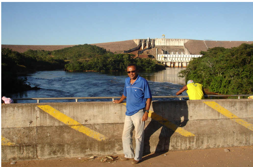
Figura 27 – APM Manso vista de jusante em ponte sobre o Rio Manso (visualização de vertedores, casa de força e canal de fuga).
