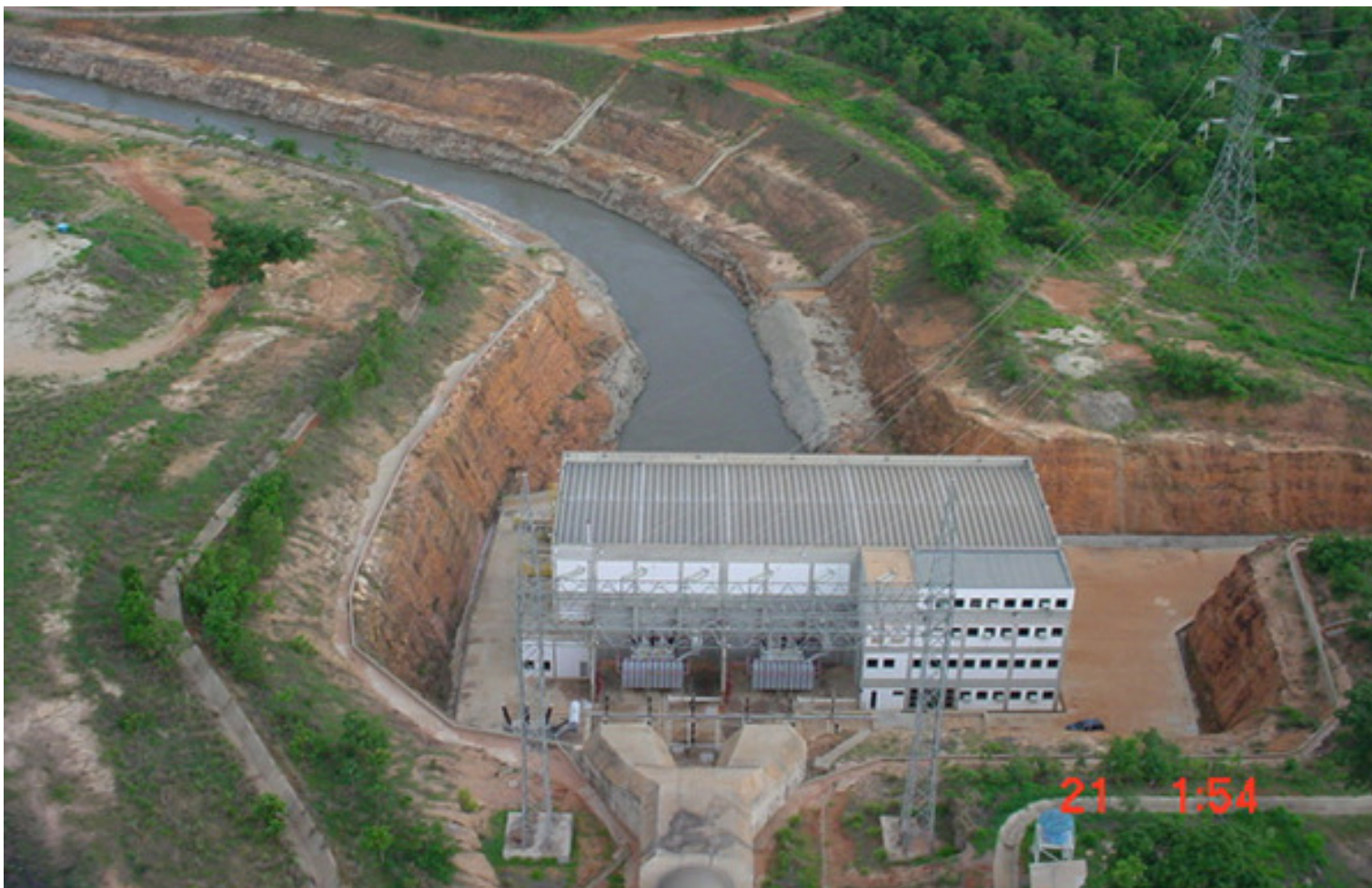
Figura 42 – AHE Itiquira, Rio Itiquira (MT). Potência instalada 156MW, área inundada 2,1 km 2 , volume total 4,8 hm 3 , início de operação outubro de 2002 e após 5 anos de operação 2/3 do reservatório está tomado por sedimentos impossibilitando a geração de energia elétrica. Foto: http://www.construtoraquebec.com.br/obras_barragens07.asp (Acesso em 20/12/2008). Fonte: ITISA, 2007.
