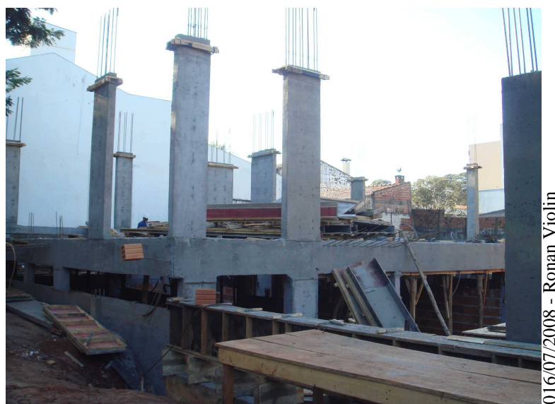
Figura 6.2.2 – Superestrutura e alvenaria – Obra C.
