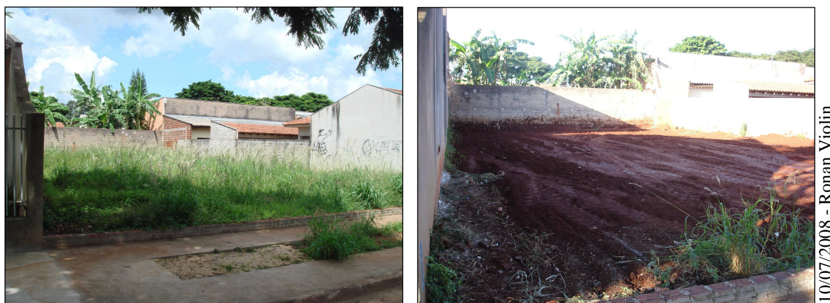
Figura 6.3.1 - Limpeza do terreno – Obra D
