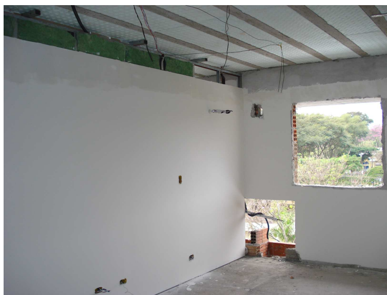
Figura 6.2.1 – Instalação de gesso acartonado e pintura – Obra A
