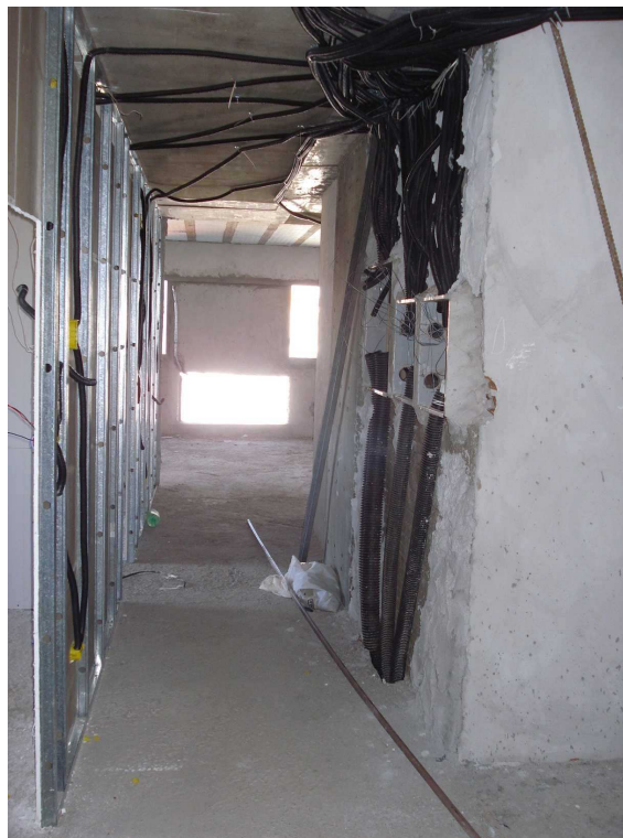
Figura 6.1.2 – Prumadas elétricas – Obra A
