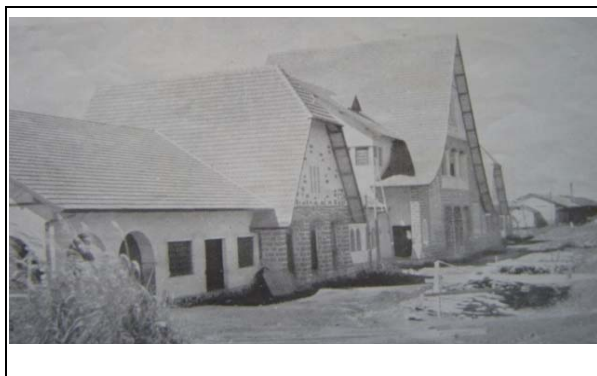
FIGURA 14 - Estação Ferroviária do Município de Londrina - Paraná
