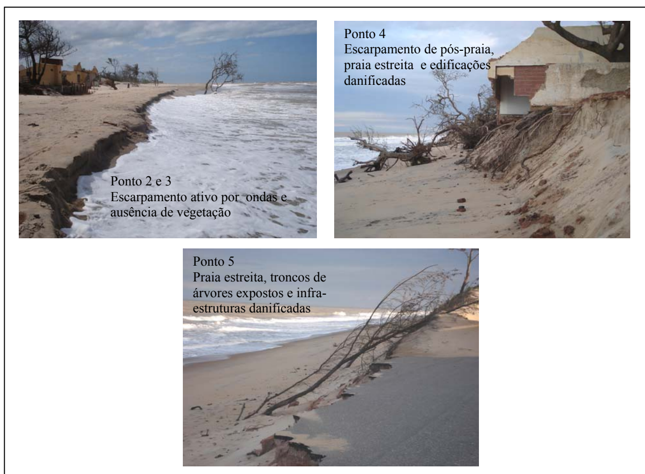
Fig. 62: Geoindicadores mapeados nos pontos 2, 3, 4 e 5, indicando estado de erosão costeira.
