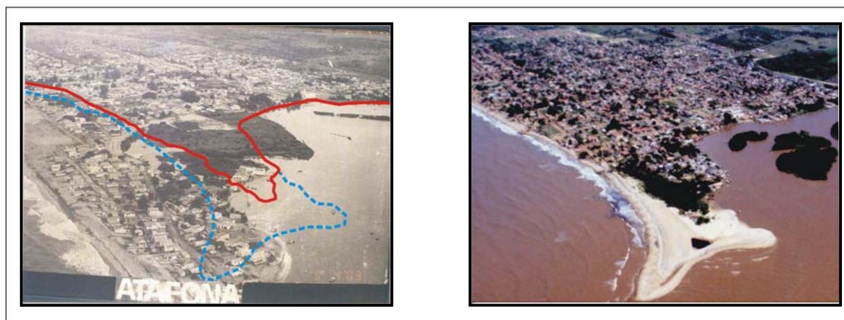
Fig. 18. Readaptação morfológica do pontal do rio Paraíba do Sul que comprometeu grande parte da estrutura urbana de Atafona. A foto da esquerda tirada no início da década de setenta, onde a linha vermelha registra a linha de costa mais estável no atual e a linha pontilhada em azul o contato do oceano com a praia. Estas linhas foram tiradas a partir da foto da esquerda registrada em 2003, em condições semelhantes de altitude e obliquidade (Santos, 2006).
