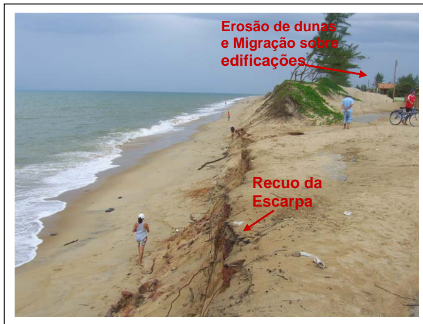
Fig.34 Fotografia tirada no ponto 5 em Fevereiro de 2008, indicando severa erosão e migração das dunas sobre edificações.
