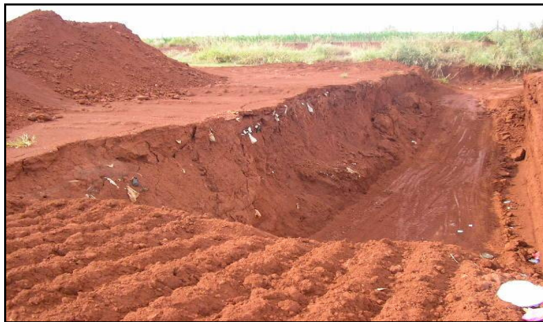
Figura 39 - Nova vala aberta no aterro controlado de Floresta/PR
