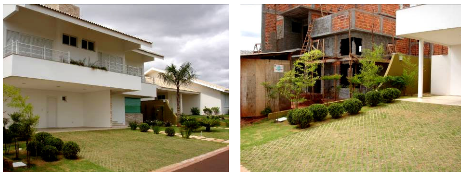
Figura 83: Ilustrações do piso grama, instalado no acesso de veículos em residência unifamiliar.
