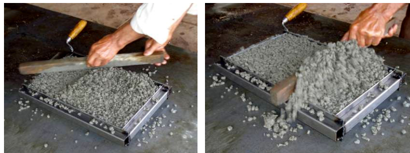
Figura 144: Regularização da superfície da peça
