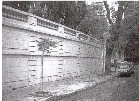
Figura 49: Vista de uma rua do bairro de Palermo, em Buenos Aires (Argentina), com faixa de estacionamento em paralelepípedo.
