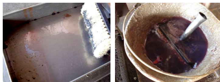
Figura 142: Fôrma untada com óleo diesel
