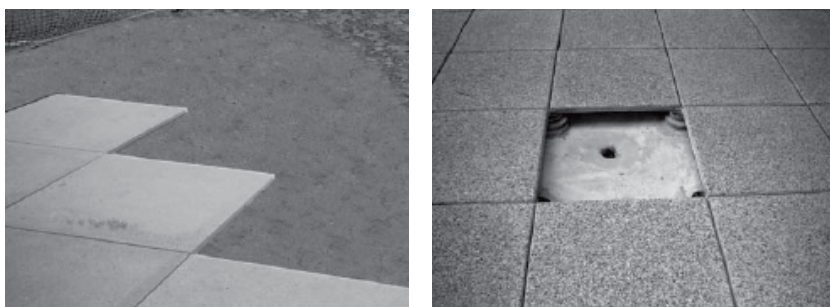
Figura 84: Ilustrações de placa pré-moldadas de concreto
