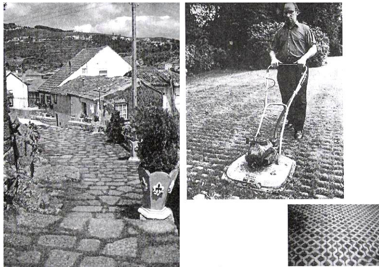
Figura 36: Escadaria com placas de pedras irregulares colocada à mão com junta aberta e pavimentação com blocos de concreto com grama e sua manutenção, respectivamente.
