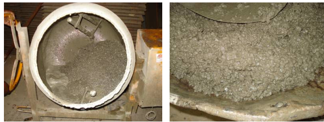
Figura 141: mistura na betoneira e posteriormente colocada na carriola
