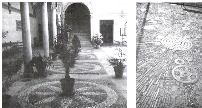
Figura 34: Exemplo de pavimentos colocados à mão com diferentes texturas e inserção de elementos variados.
