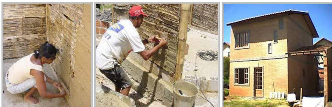
Figura 8 – Nas fotos da esquerda e centro, protótipo de habitação sendo construído pela própria comunidade em Maceió – AL (Fonte: OLIVEIRA, 2006); e a direita, moradia feita com tijolos de solocimento (Fonte: CARDOSO, 2006).
