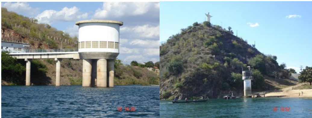
Figura 46: Sistema de captação das águas do rio São Francisco que margeia a sede do município de Pão de Açúcar – AL (Fonte: IMA-AL, 2007).
