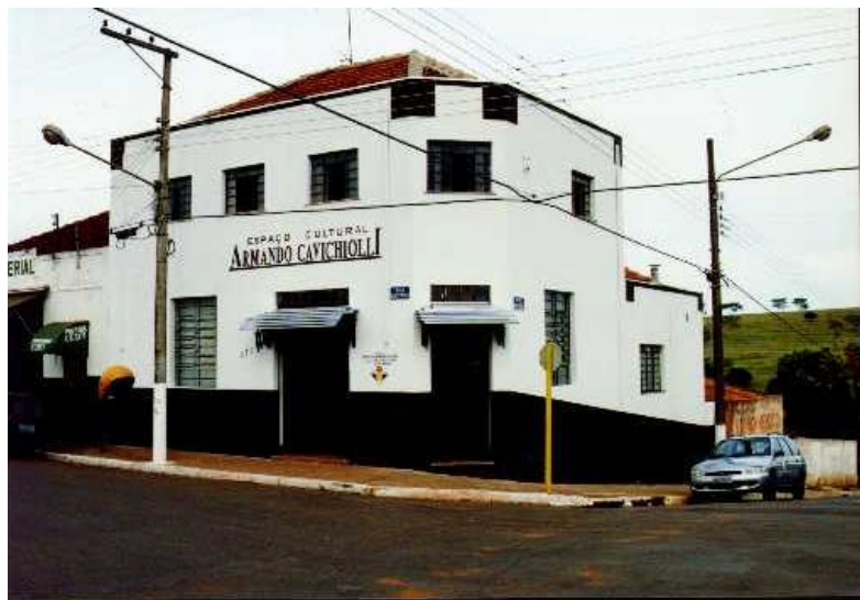
Foto 1: Fachada do Centro Cultural Armando Cavichioli e Museu do Índio de Iepê, Município de Iepê, SP, após restauração 2 .
