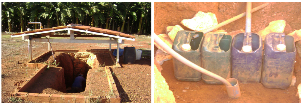
Figura 7. Estação coletora dos dois lisímetros de drenagem e pontos de coleta da água drenada, Limoeiro do Norte, Fazenda FRUTACOR
