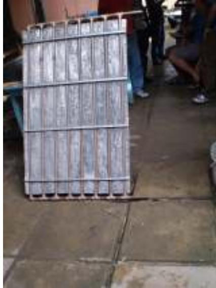
Figura 3.3. Fixação da grade absorvedora na chapa absorvedora.
