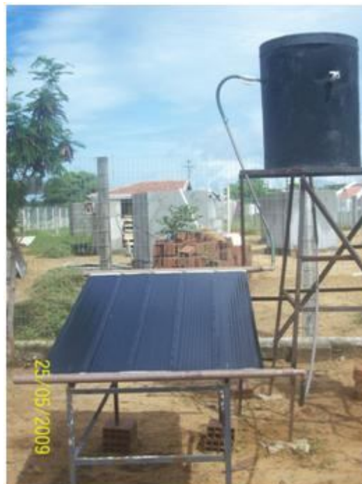
Figura 3.17. Teste de Vazamento.
