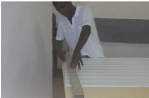
FIGURA 3.4. Marcação das placas de PVC.
