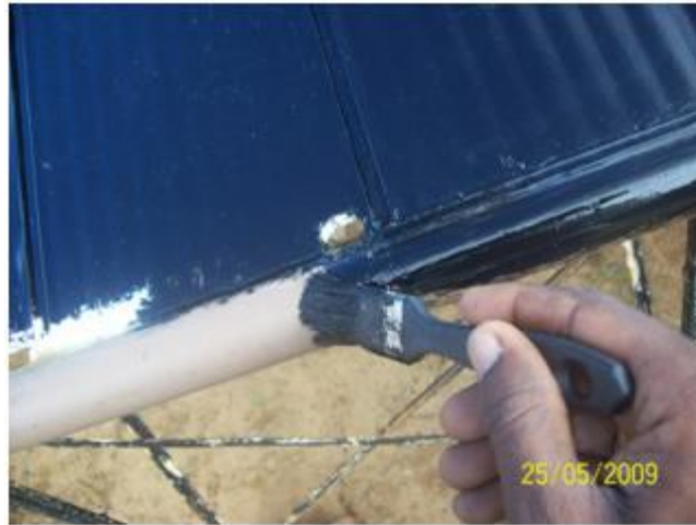
FIGURA 3.18. Acabamento final do coletor.
