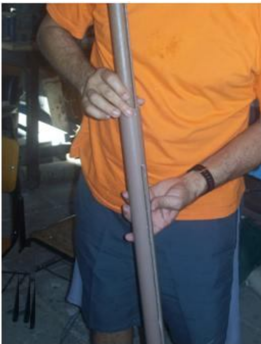
FIGURA 3.6. Colocação do tubo Ø32 mm no interior do tubo de Ø40 mm.
