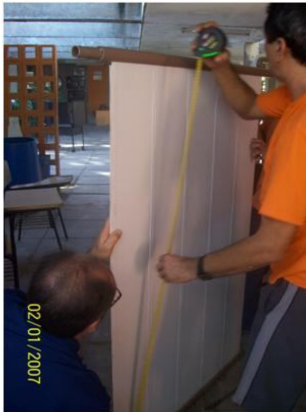
Figura 3.10. Verificação das dimensões do coletor antes da aplicação da resina Isoftálica.
