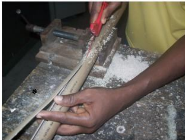
Figura 3.2. Abertura do rasgo nos tubos de distribuição de água.
