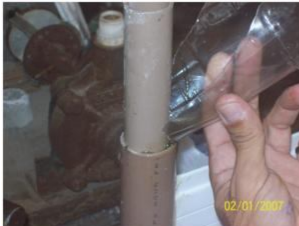
Figura 3.12. Aplicação da Resina Isoftálica por entre os tubos de distribuição.
