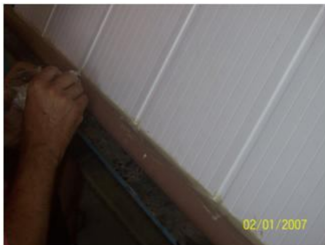
Figura 3.11. Utilização da resina Isoftálica para fixação da Placa ao tubo de distribuição.
