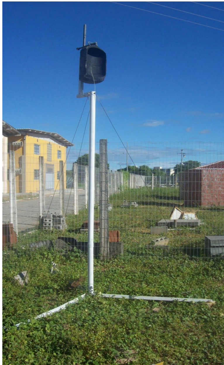
Figura 3.13. Absorvedor no topo da torre.
