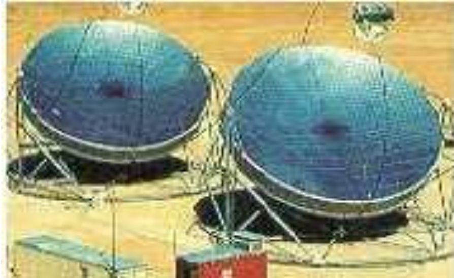
Figura 2.20. Protótipos Dish-Stirling na Arábia Saudita
