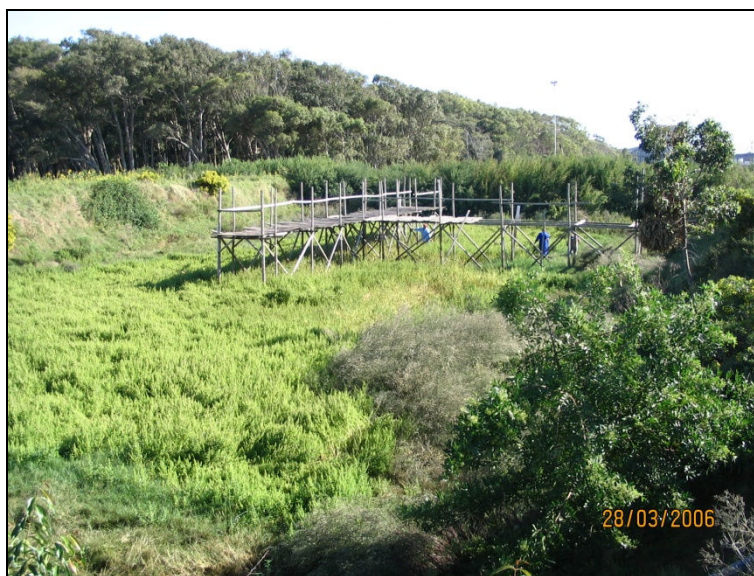
Figura 2.3 – Fotografia da bacia de sedimentação leste, construída em 2001, para receber sedimentos lamíticos dragados na área do porto Novo.
