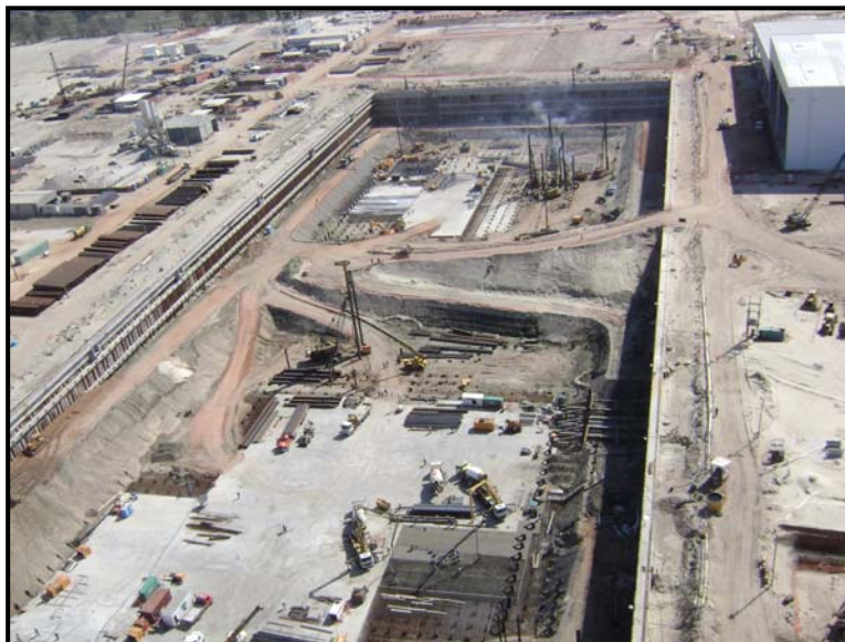
Figura 1.3 – Vista área do dique seco do Estaleiro Rio Grande
