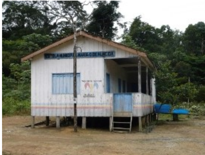
Figura 13 – Sede da Comunidade São Francisco de Assis.
