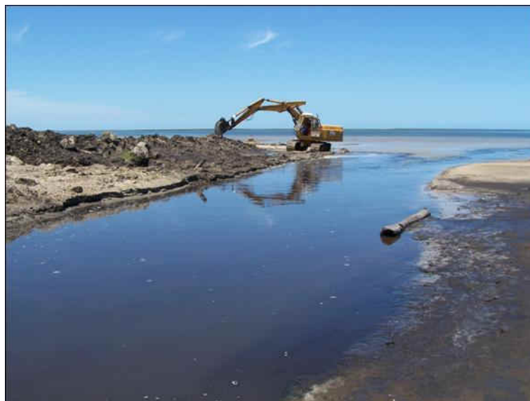
FIGURA 3.13 – Canal de drenagem situado na margem Oeste da Lagoa Mangueira
