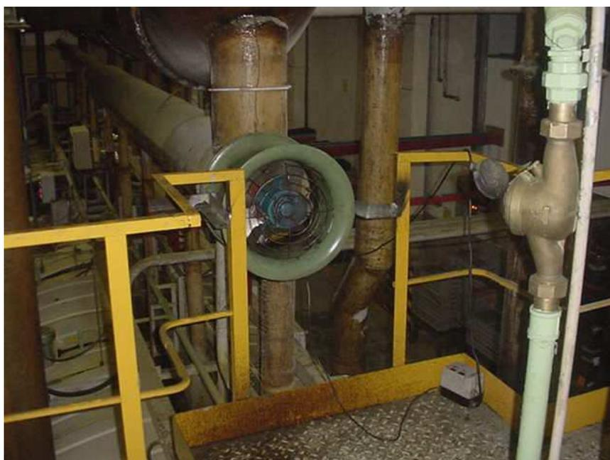
**Figura 41:** Tubulação o sistema de exaustão depois da instalação do ventilador.
