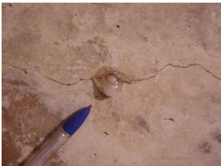
Figura 5 - Detalhe do gel exsudado na superfície da estrutura de concreto da UHE-Furnas (HASPARYK, 2005).
