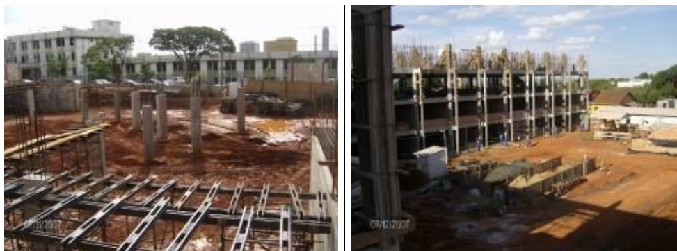
Figura 6.1 – Fotos do edifício em construção.
