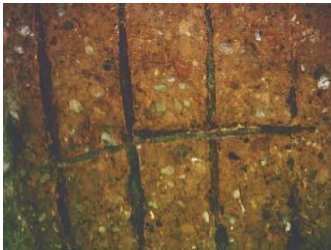
Figura 4.7 – Foto da laje da escada da igreja em Romaria-MG.
