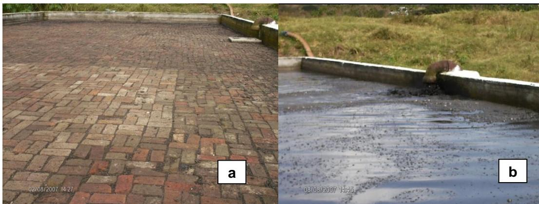
**Figura 07:** Preparação do leito de secagem para coleta do lodo e esgoto. ETE Contorno, Feira de Santana, BA: a) leito limpo e seco; b) descarga do lodo no leito.
