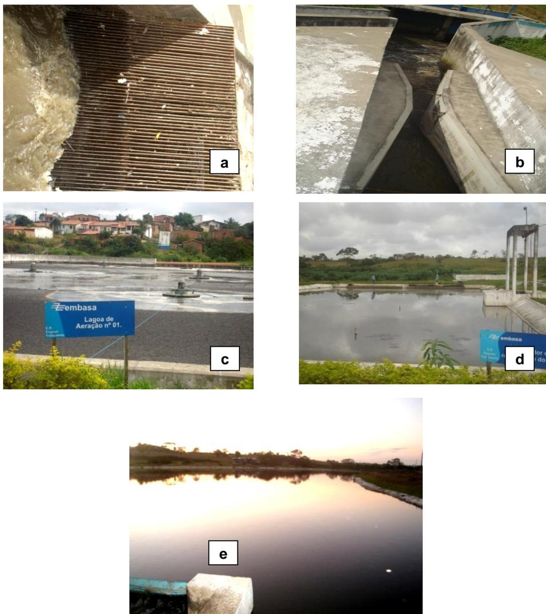
**Figura 04:** ETE Contorno, Feira de Santana, Bahia. (a) Gradeamento (b) Caixa de areia (c) Lagoa de Aeração (d) Decantador de lodo (e) Lagoa de Sedimentação
