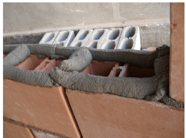
Figura 6.3: Montagem de parede para teste de isolamento sonora, com detalhe à colocação da argamassa.
