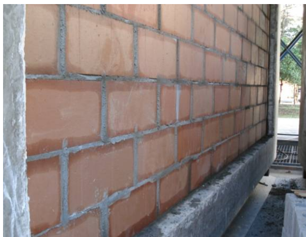
Figura 7.14: Montagem da parede no pórtico do laboratório.
