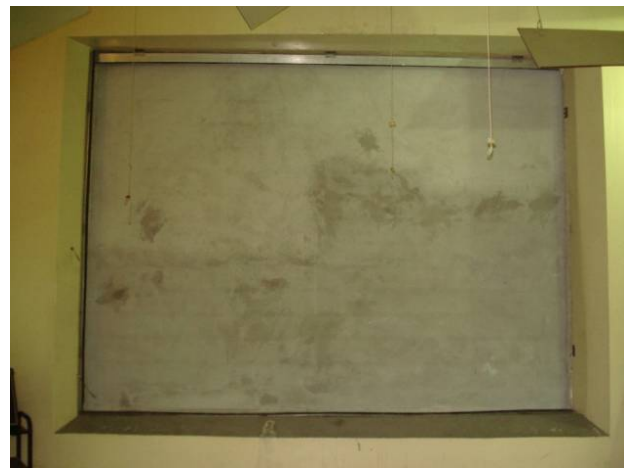
Figura 7.3: Parede posicionada entre-câmaras para a realização do teste de isolamento sonora.
