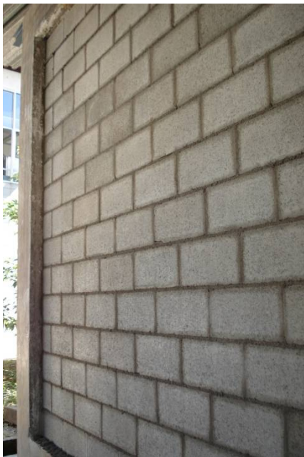
Figura 7.6: Parede construída para o teste de isolamento sonora.
