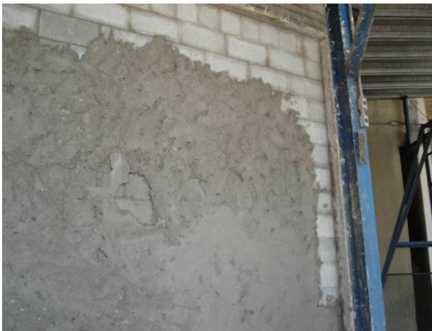
Figura 7.2: Montagem da parede, com visão para o preenchimento das juntas verticais e horizontais e a colocação da argamassa.
