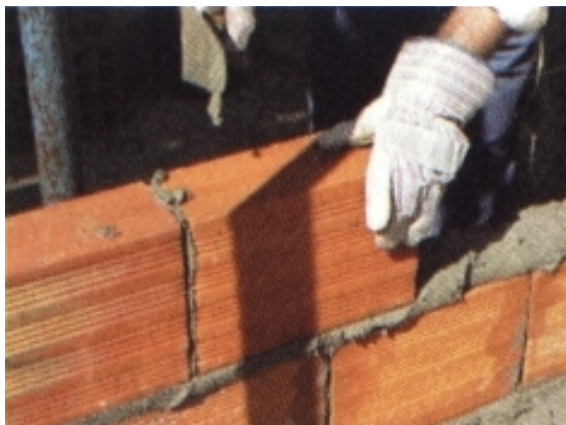
Figura 6.4: Construção de parede de tijolos cerâmicos, em Portugal, com o uso da pá de pedreiro e, no detalhe, uma peça de tijolo cerâmico. (APICER, 2000).
