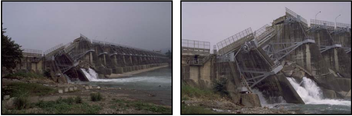
Figura 1.2 – Acidente na barragem de ShihKang em 1999 ( http://nisee.berkeley.edu/library ).
