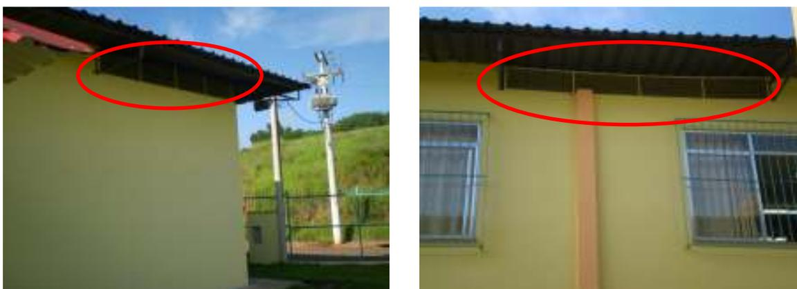
Fig. 104 e 105 – Sistema de resfriamento das lajes – vista na fachada principal e lateral.
