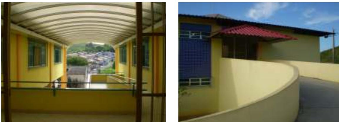
Fig.74 e 75 – Rampa entre as alas B e C e a segunda rampa localizada ao final do corredor principal.
