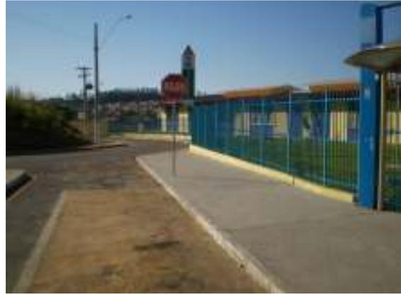
Fig. 120 e 121 – Rampa do estacionamento e acesso principal sem rampas.
