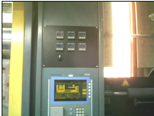
Figura 30 – Painel de controle de temperatura de câmara-quente (após melhoria). Fonte: Empresa estudada.
