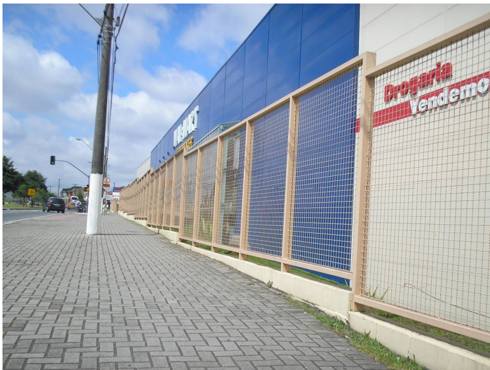
Foto 32: Wal-Mart: fachada com grades próximas às paredes externas do supermercado, aproveitamento total do espaço e forte isolamento do “fora” com o “dentro”.
