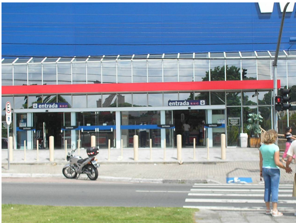
Foto 29: Wal-Mart: duas entradas e saídas para os pedestres.
