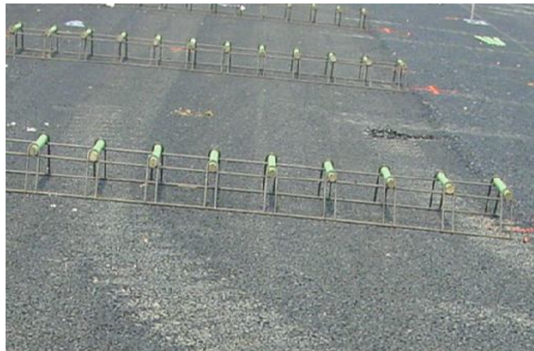
Figura 2.14 – Colocação de barras circulares metálicas (SNYDER, 2007).
