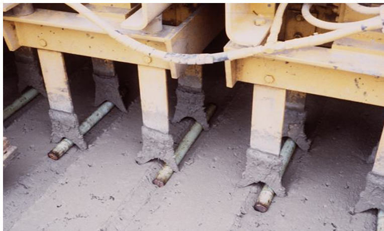
Figura 2.15 – Pavimentadora inserindo barras de transferência de carga na execução do pavimento de concreto. (SNYDER, 2007)
