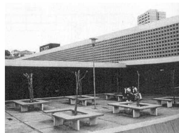
**Foto 3.04.3\_**Fachada Leste: Nesta face foi utilizado elemento vazado de concreto como vedo. Logo atrás deste está a circulação do pavimento superior, que serve às salas de aula e de datilografia.
