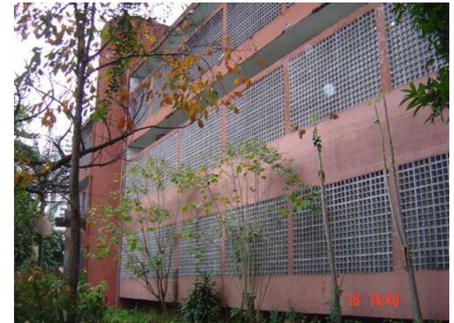
**Figura 3.29.4\_** O jardim lateral, embeleza o acesso ao edifício. Em ambas as faces o elemento vazado associa efeito estético e protege da incidência de raios solares.
