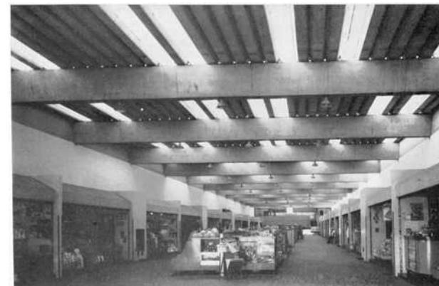
**Foto 3.24.2\_** O galpão possui farta iluminação natural, proveniente das telhas de fibra de vidro intercaladas com as telhas de fibrocimento. Ao centro os quiosques e nas laterais as lojas. Tudo em concreto armado aparente, ou simplesmente pintado.
