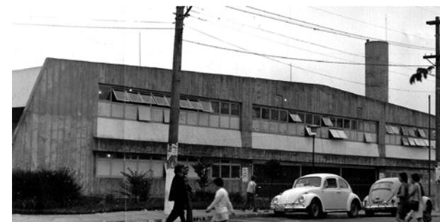
**Foto 3.13.1** Fachada para a rua Paraíso. Há claramente na fachada a marcação da estrutura, dividida em três vãos: ambientes fechados nas laterais e um grande pátio aberto porém coberto ao centro
