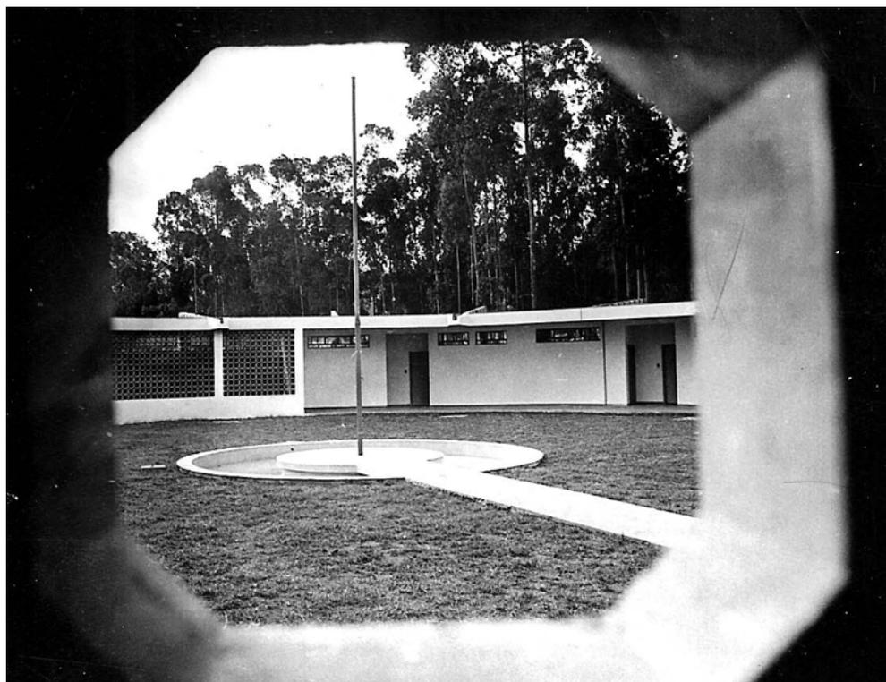
**Figura 3.15.4\_** Vista do pátio interno através da divisória de elemento vazado, que fica logo no acesso principal. No lado oposto, em frente a uma das salas de aula, há uma parede como esta também. Consegue-se perceber bem a cobertura em laje, que protege o corredor que circunda todo o projeto. O elemento de destaque, ao centro da fotografia, é o mastro da Bandeira Nacional, envolto por um espelho d'água.
