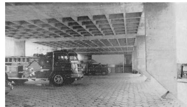
**Foto 3.18.2\_** Garagem de viaturas dos bombeiros. A imagem permite observar o detalhe do ponto de apoio. Esta composição, de "afinar" o pilar junto ao chão, da sensação de leveza e esta presente em outros projetos, como no Tiro de Guerra de Kanawaza (1964, ficha 16).
