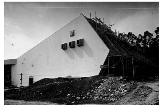
**Foto 3.09.2\_** Durante as obras. Destaque para os beirais, que recobrem as janelas dos sanitários, ao mesmo modelo do adotado por Kanawaza no Tiro de Guerra.
