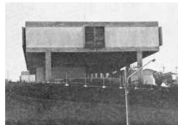
**Foto 3.10.6\_** O grande vazio formado pelos pilotis e ao centro as esquadrias que iluminam a circulação do pavimento superior.
