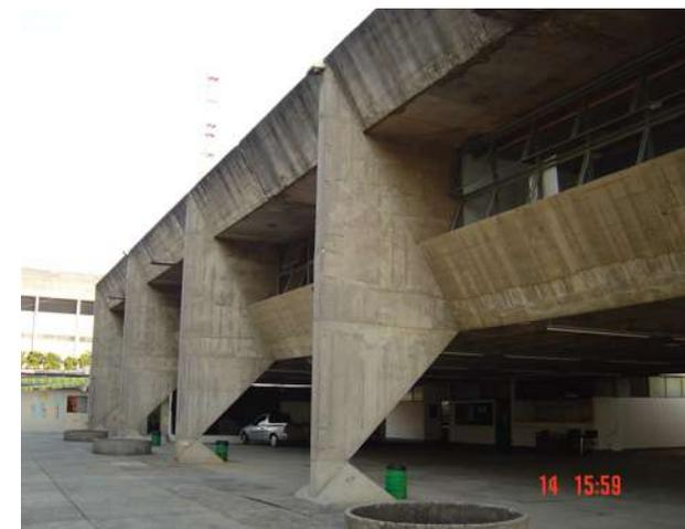
**Foto 3.06.2 e 3** A intenção de fazer o pilar “cantar no ponto de apoio” é observada nas pirâmides que apoiam a base dos pórticos. O desenho puramente como imaginado pelo autor, não seria capaz de suportar o alto momento de força na base do pilar, necessitando um reforço. Este artifício é comum e podemos vê-lo também no projeto do Corpo de Bombeiros da ficha 21. Na foto abaixo podemos ver o espaço formado pelos pilotis. Um grande vão de 25 metros. Um dos maiores analisados neste Inventário.
