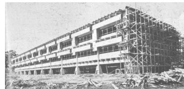
**Foto 3.17.2\_** Vista durante as obras, a partir do estacionamento de estudantes. O pavimento térreo, livre e sob pilotis pode ser visto aqui, uma vez que ao longo do tempo sofreu acréscimos de área, perdendo a liberdade visual e possibilidade de permeabilidade por qualquer pilar.
