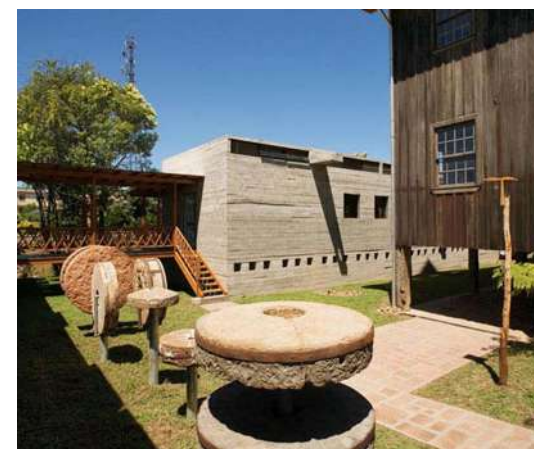
Figuras 402 e 403 – Prédios Novos (Museu do Pão – superior; Escola de Panificação – inferior). Fotos: Nelson Kon – Fonte: Acervo do escritório Brasil Arquitetura.
