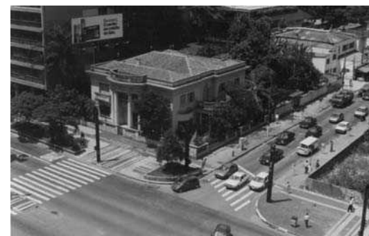
Figura 175 – Vista Geral antes da intervenção.
