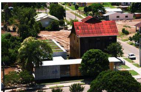
Figura 413 - Vista do conjunto. Foto: Nelson Kon – Fonte: Acervo do escritório Brasil Arquitetura.
