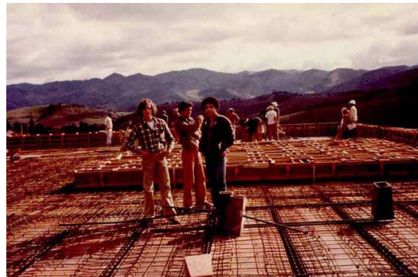
Figura 568 – Arquitetos Marcelo Ferraz e Marcelo Suzuki na obra. Fonte: Acervo do escritório Brasil Arquitetura.
