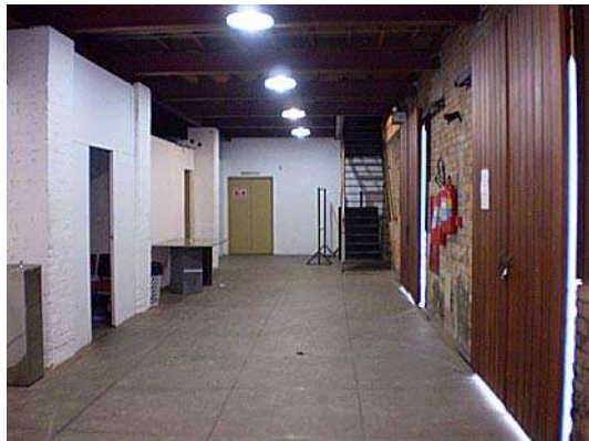
Figura 226 – Subsolo após a intervenção.
