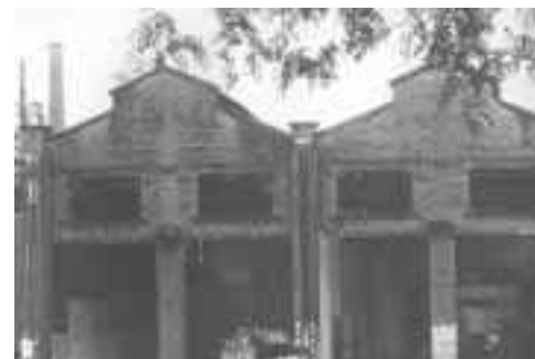
Figuras 275 e 276 – Prédios 09 e 10.
