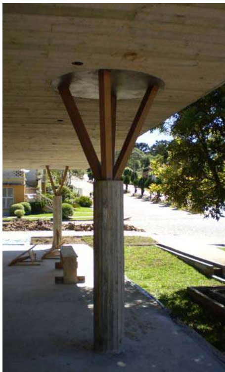
Figura 407 – Detalhe do pilar do Museu do Pão, em obras. Foto: Patricia Viceconti Nahas.
