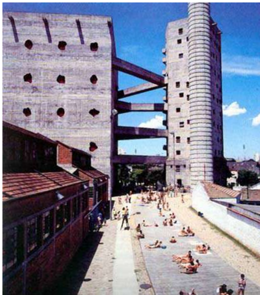
Figura 015 – Edifícios esportivos do Sesc Pompéia. Fonte: Acervo de escritório Brasil Arquitetura.
