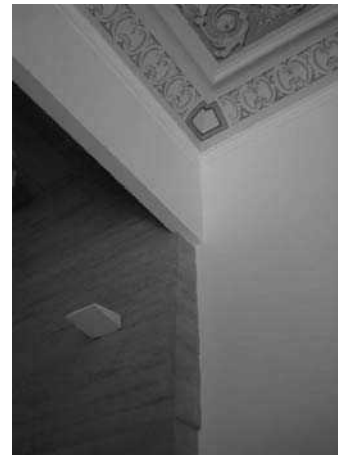
Figura 337 (B) – Detalhe da junção do novo ao velho na implantação da nova circulação vertical no palacete. Foto: Patricia Viceconti Nahas.
