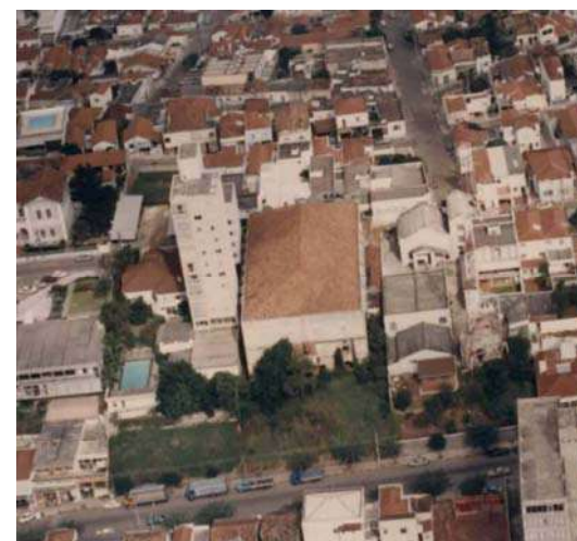
Figura 210 e 211 – Vista aérea do Teatro Polytheama: frente (acima) e fundos (abaixo). Fonte: Acervo do escritório Brasil Arquitetura.
