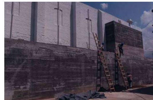
Figura 228 – Vista externa da galeria lateral após a intervenção. Fonte: Acervo do Escritório Brasil Arquitetura.
