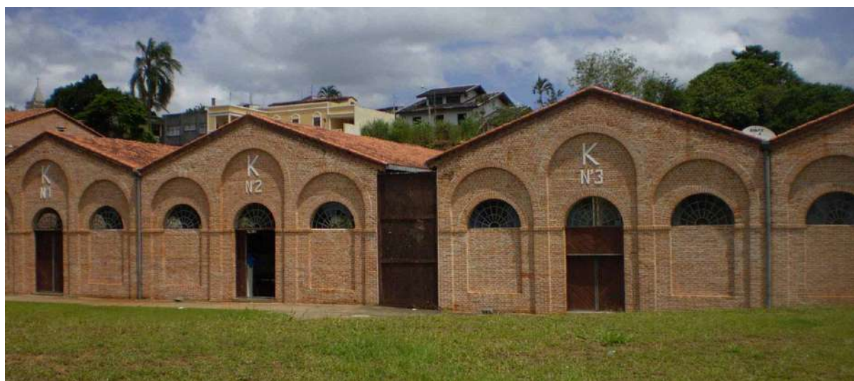
Figura 266 – Galpões KKKK, após a intervenção. Foto: Patricia Viceconti Nahas.
