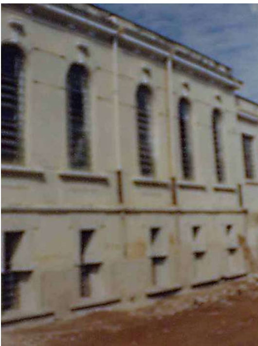
Figura 058 – obras no subsolo da escola Prof. Dantes. Fonte: arquivo do FDE.
