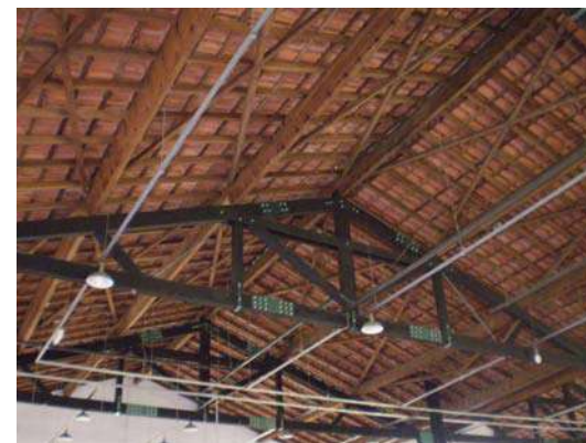
Figura 264 – Detalhe da cobertura dos galpões K3+K4, após a intervenção. Foto: Patricia Viceconti Nahas.
