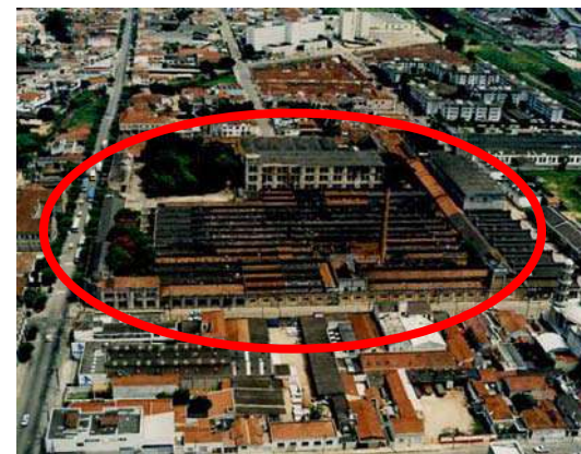
Figura 131 – Vista aérea dos remanescentes das Indústrias. Fonte: Acervo do escritório Brasil Arquitetura.
