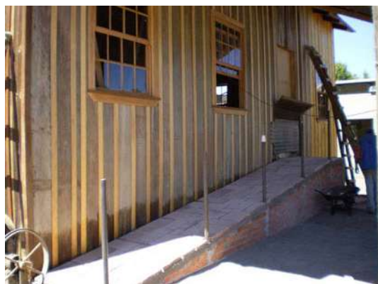
Figura 401 – Rampa de acesso à bodega, em obras (outubro de 2007). Foto: Patricia Viceconti Nahas.
