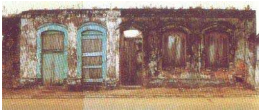
Figura 100 – Edificação em Cananéia antes da intervenção. Fonte: FERRAZ, 1993, p. 308.
