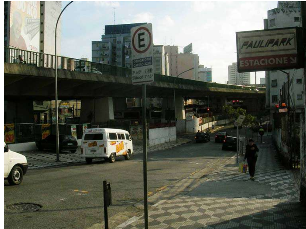
Figura 367 – Local para intervenção nos baixos do viaduto. Fonte Acervo do Escritório Brasil Arquitetura.
