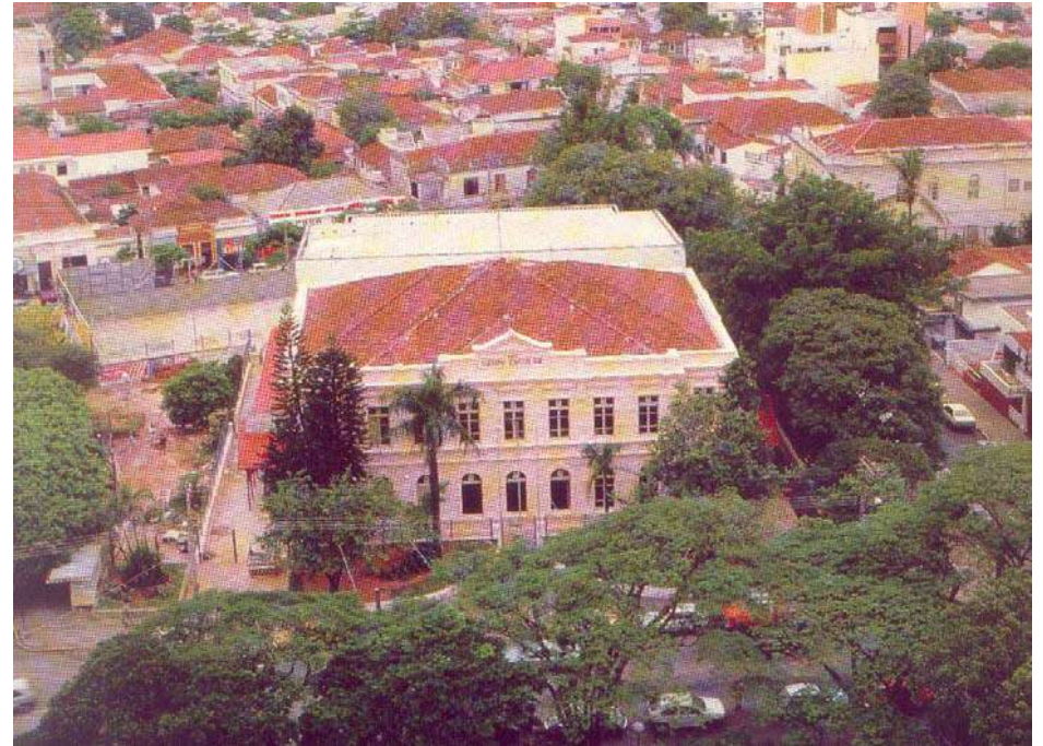
Figura 123 – Vista geral do conjunto após a intervenção. Fonte: FERREIRA, 1998, p.93.
