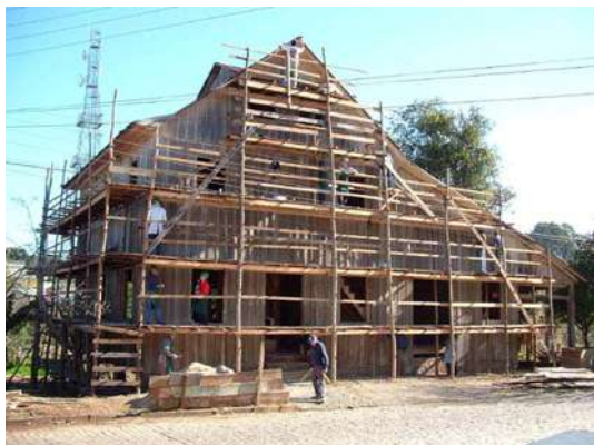
Figura 384 – Fachada nordeste durante restauro da Escola-obra. Fonte: Acervo do escritório Brasil Arquitetura.
