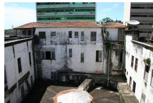
Figura 511 – Vista geral da edificação existente.
