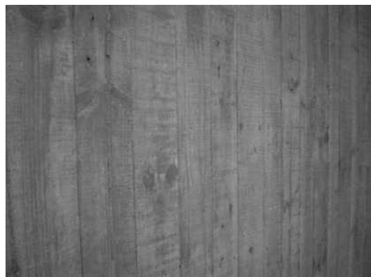
Figura 498 – Detalhe da parede de concreto riado do Museu do Pão. Foto: Patricia Viceconti Nahas.
