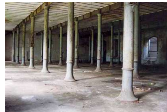
Figura 239 – Estrutura metálica utilizada na construção. Fonte: Acervo do escritório Brasil Arquitetura.
