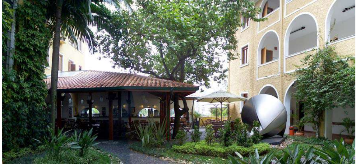
Figura 461 – Vista do pátio interno, antes da intervenção. Foto: Francisco Fanucci.
