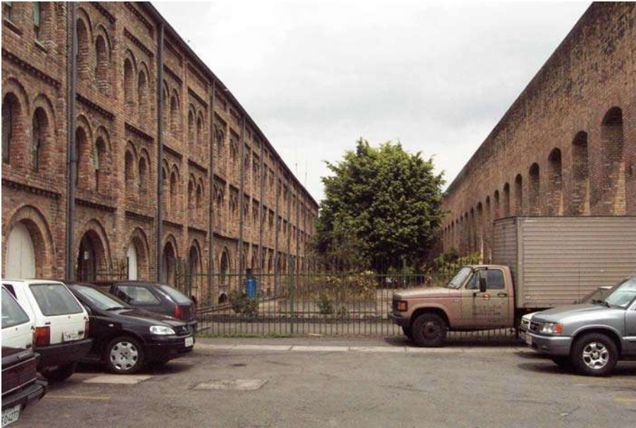
Figura 419 – Conjunto das Retortas, estado atual. Fonte: Acervo do escritório Brasil Arquitetura.
