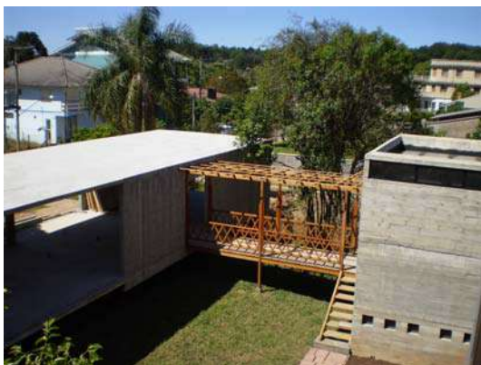
Figura 449 – Ligação entre os prédios, em obras – outubro de 2007. Foto: Patricia Viceconti Nahas.
