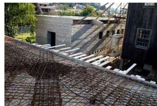
Figura 406 – Execução da laje de cobertura do Museu do Pão. Fonte: Acervo do escritório Brasil Arquitetura.
