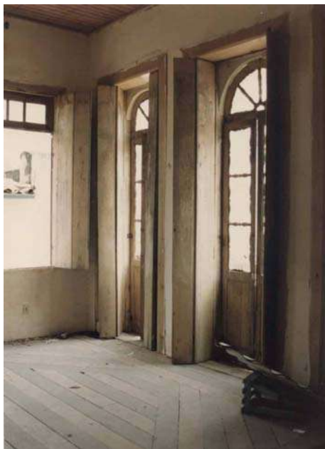
Figura 080 – Interior da residência antes do restauro. Fonte: Acervo do escritório Brasil Arquitetura.
