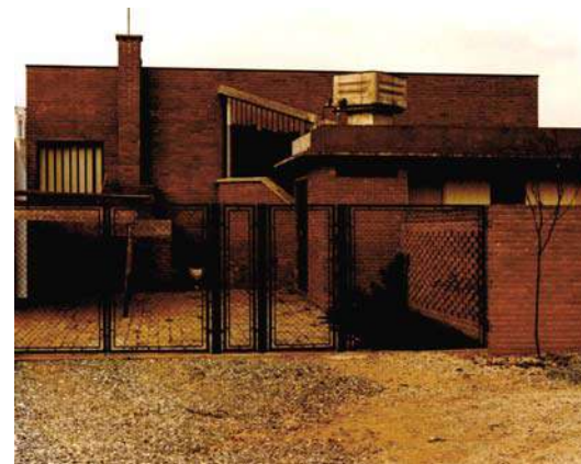
Figura 052 – Residência Kawahara. Fonte: Acervo do escritório Brasil Arquitetura.
