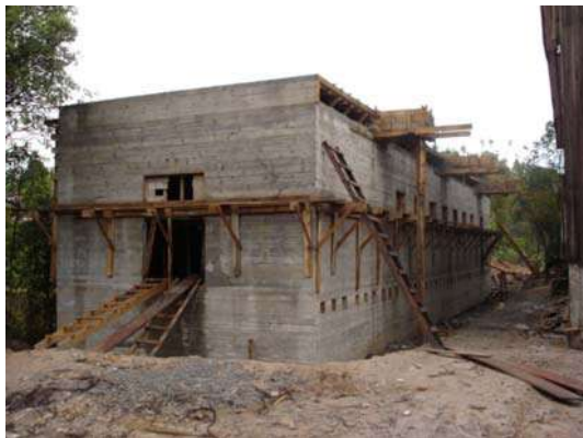
Figura 456 – Escola de Panificação (em obras) do Museu do Pão. Fonte: Acervo do escritório Brasil Arquitetura.
