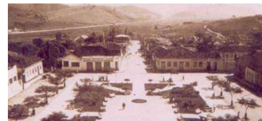
Figura 005 - Vista da Praça Coronel Justiniano, na década de 1960, para o local onde foi construído o Paço Municipal (esquina à direita). Foto: autor desconhecido.
