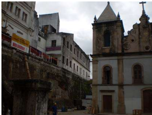
Figura 021 – Vista atual do conjunto da Barroquinha. Foto: Patricia Viceconti Nahas.
