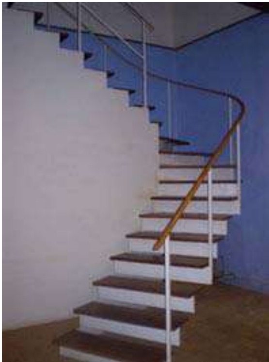
Figura 255 – Escada executada. Foto: Patricia Viceconti Nahas.
