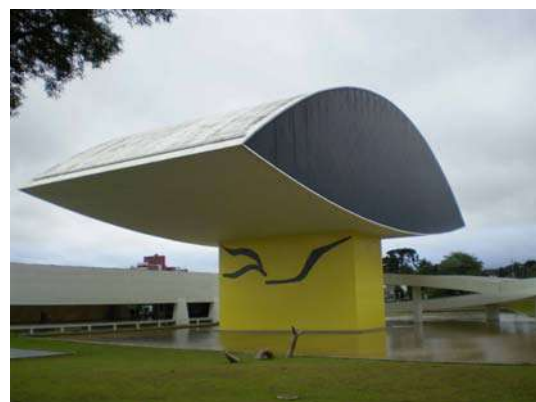
Figuras 339 (acima) e 340 (ao lado) – Edifício Castelo Branco depois da intervenção; Novo Museu. Fotos: Patricia Viceconti Nahas
