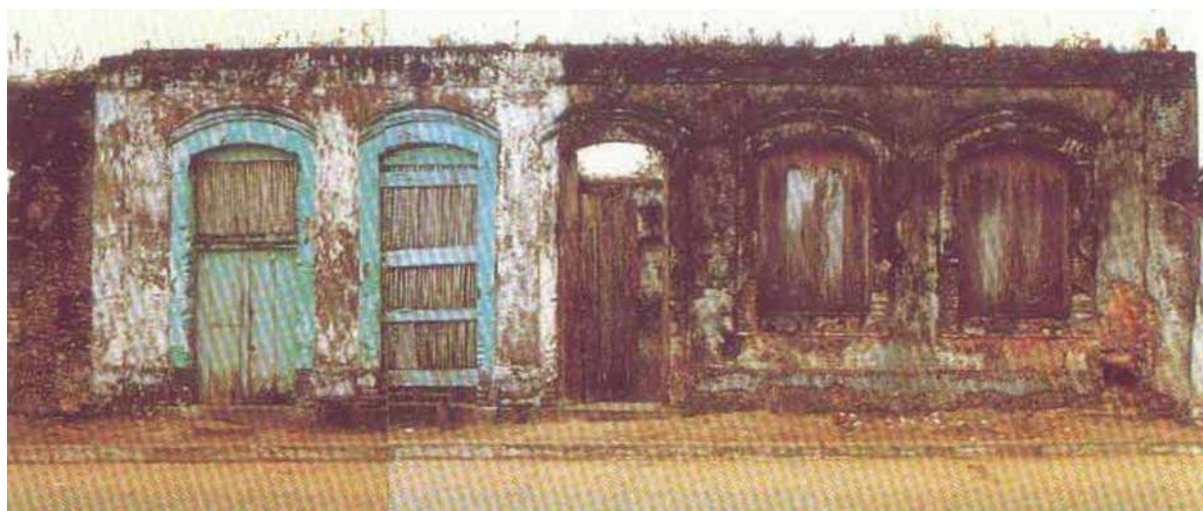
Figura 069 – Edificação antes da intervenção.
