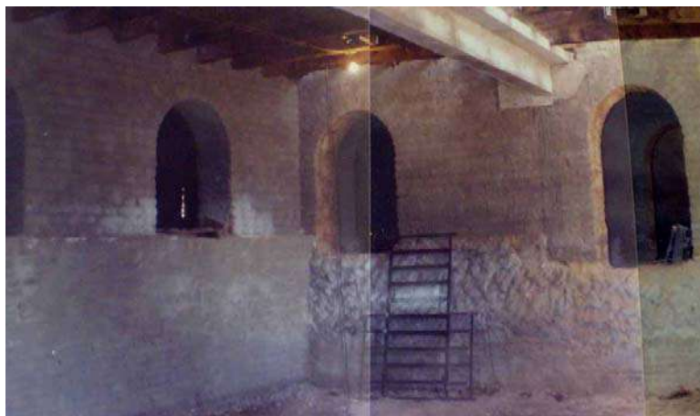
Figura 570 – Subsolo da escola em obras. Fonte: Acervo do FDE.
