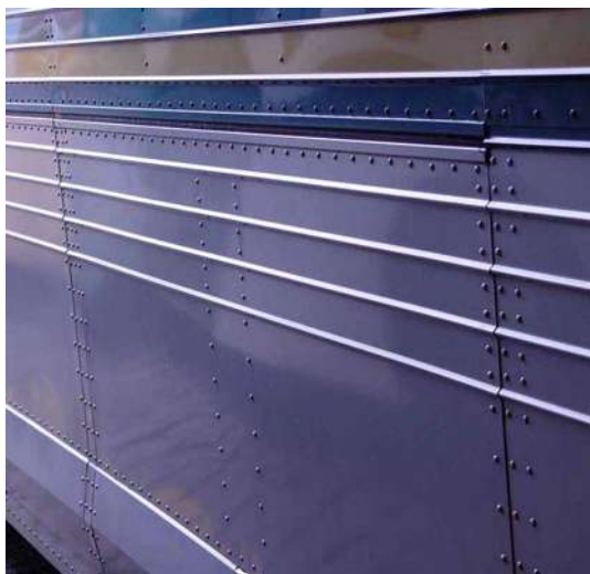
Figura 504 – Chapa metálica ara fechamento dos prédios novos no Centro Cultural de Araras. Fonte: Acervo do escritório Brasil Arquitetura.
