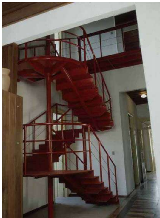
Figura 083 – Implantação antes da intervenção. Fonte: Acervo do escritório Brasil Arquitetura.
