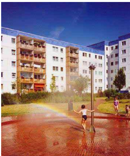
Figuras 132 e 133 – Bairro Amarelo antes e depois da intervenção. Fonte: Acervo do escritório Brasil Arquitetura.
