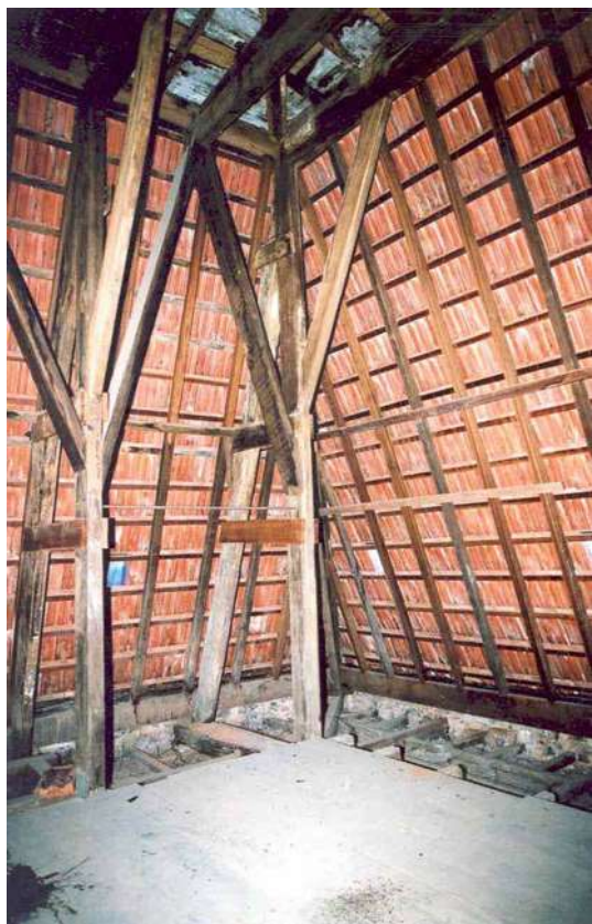
Figura 328 (acima) – Sótão antes da intervenção. Fonte: Acervo do escritório Brasil Arquitetura.
