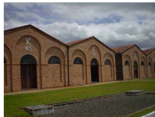
Figura 255 – Prédios dos galpões, após a intervenção. Foto: Patricia Viceconti Nahas.
