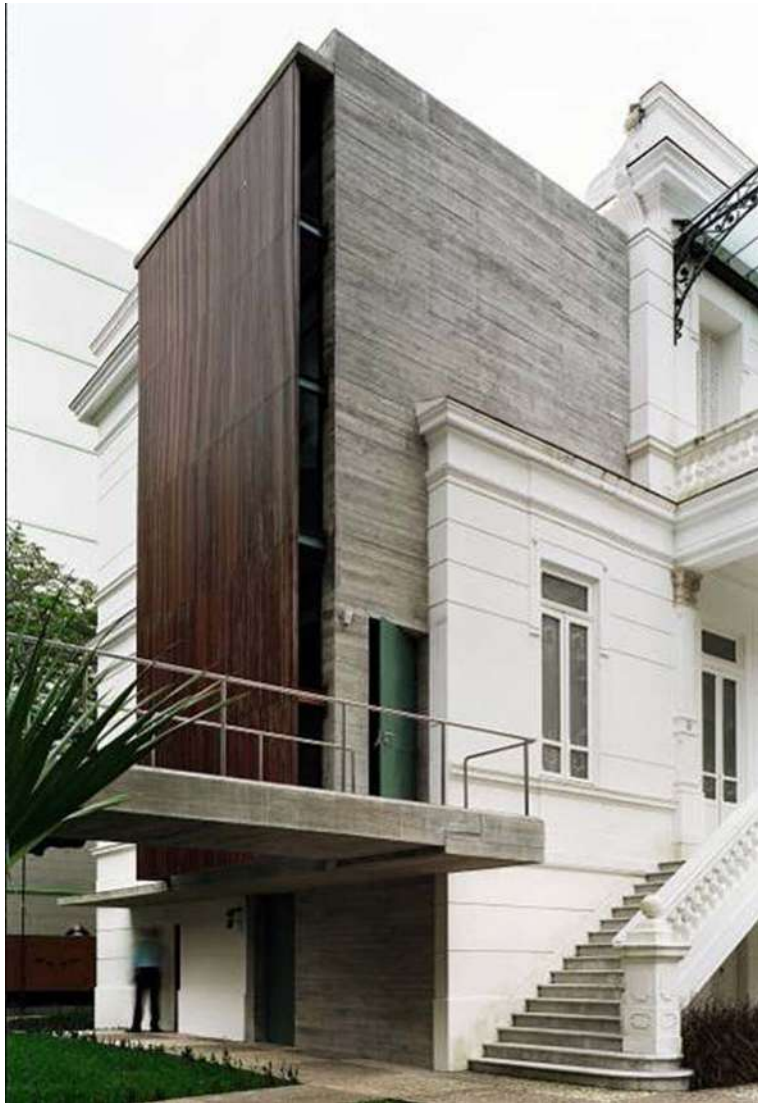
Figura 233 – Circulação nova no prédio antigo. Foto: Nelson Kon.
