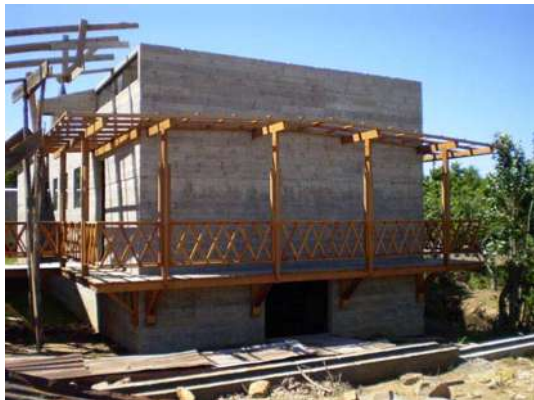
Figura 422 – Execução do passadiço, ainda em obras. Foto: Patricia Viceconti Nahas
