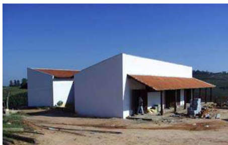
Figura 076, 077, 078, e 079 – Residências Cotia, São Francisco Xavier, Mantiqueira e Sítio Capoeira Grande. Fonte: Acervo do escritório Brasil Arquitetura.
