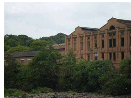
Figura 302 – Estado atual dos prédios 05 e 07. Foto: Patricia Viceconti Nahas.
