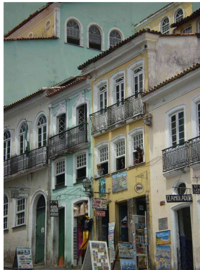
Figura 046 – Local (edificação em amarelo) onde seria implantada a Fundação Pierre Verger . Foto: Patricia Viceconti Nahas.
