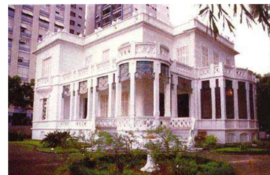
Figura 434 – Vista da Pinacoteca Benedito Calixto – edificação existente. Fonte: Acervo do escritório Brasil Arquitetura.
