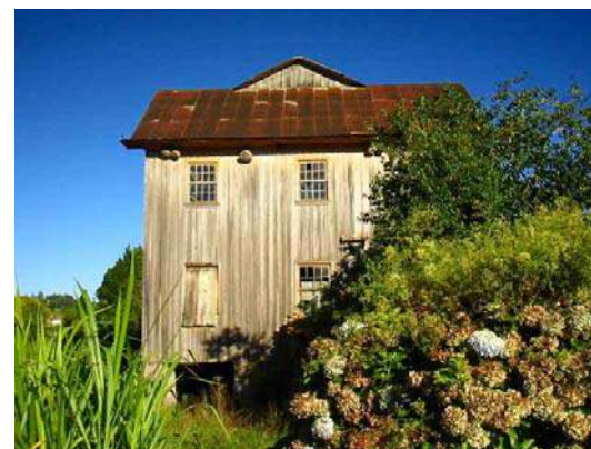
Figura 445 e 446 – Moinho de Ilópolis antes da intervenção. Fonte: Acervo do escritório Brasil Arquitetura.
