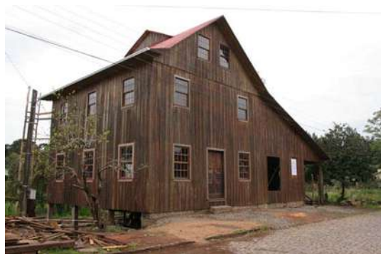
Figura 385 – Fachadas após restauro da Escola-obra. Fonte: Acervo do escritório Brasil Arquitetura.
