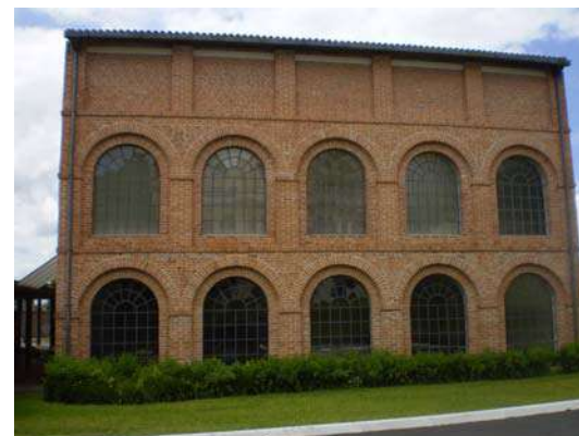
Figura 254 – Prédio do engenho, após a intervenção. Foto: Patricia Viceconti Nahas.
