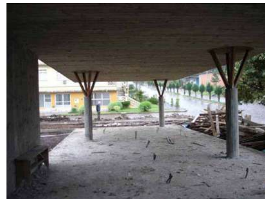
Figura 405 – Museu do Pão ainda em obras. Fonte: Acervo do escritório Brasil Arquitetura.
