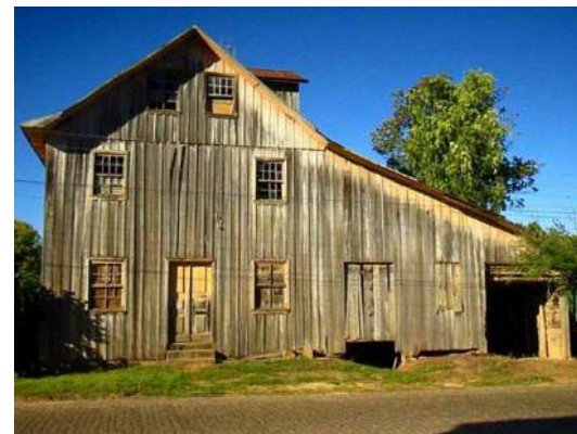
Figura 367 – Moinho Colognese antes da intervenção. Fonte: Acervo do escritório Brasil Arquitetura.
