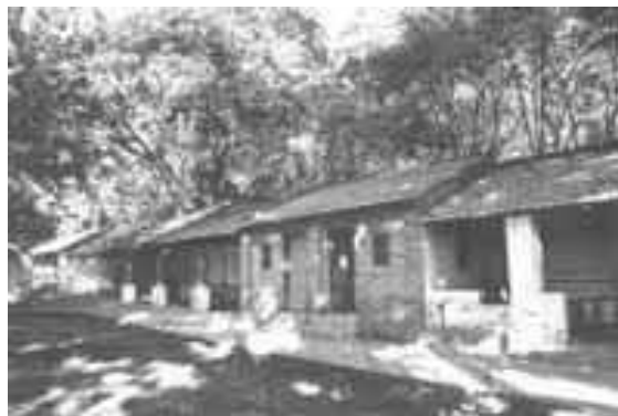
Figura 266 – Conjunto do prédio 03 – antigo Apoio Administrativo. Foto Anália Amorini.
