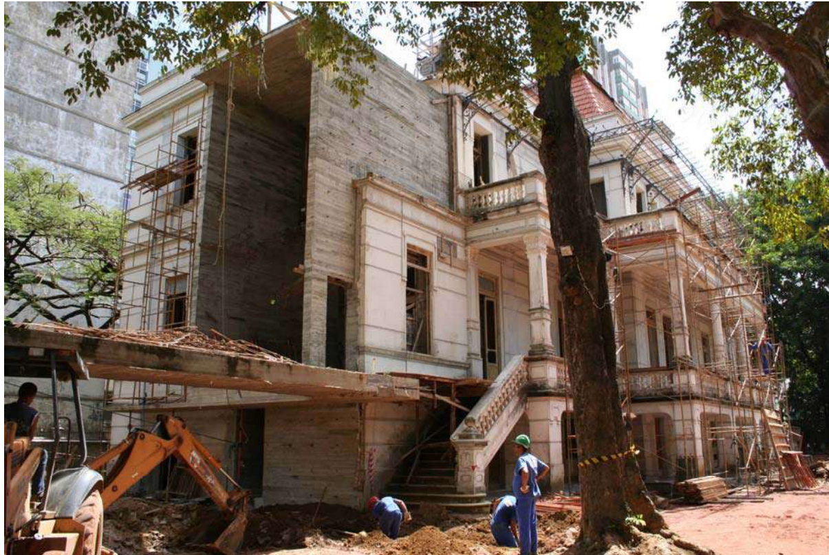
Figura 336 (A) – Obra de implantação da nova circulação vertical no palacete. Fonte: Acervo do escritório Brasil Arquitetura.
