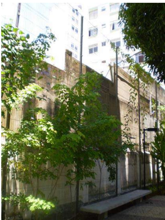
Figura 356 – Execução do muro verde após a intervenção. Foto: Patricia Viceconti Nahas.
