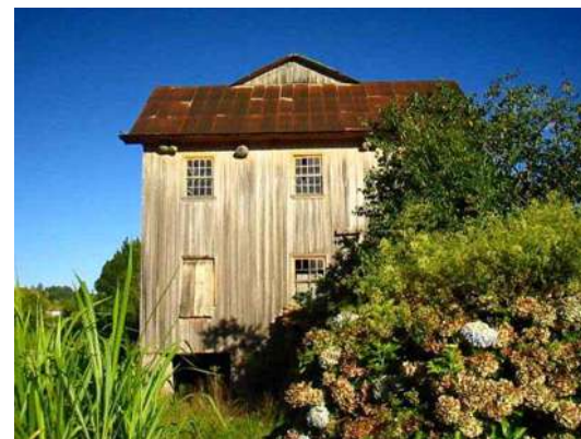
Figura 368 – Moinho Colognese antes da intervenção. Fonte: Acervo do escritório Brasil Arquitetura.
