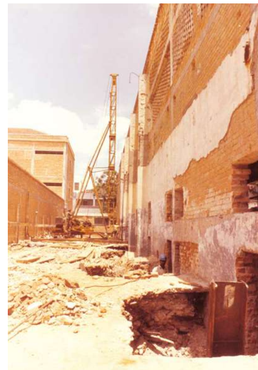
Figura 012 – Galpões do Sesc em 1979, antes da reforma. Foto: Paquito – Fonte: Acervo o escritório Brasil Arquitetura.
