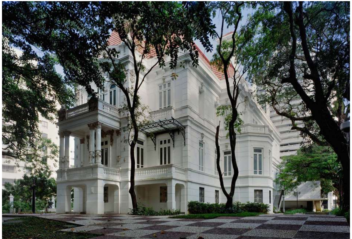
Figura 312 – Palacete Bernardo Catharino após a intervenção. Foto: Nelson Kon – Fonte: Acervo do escritório Brasil Arquitetura.
