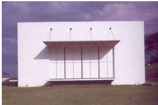
Figura 280 – Abertura dos fundos do palco do teatro-auditório. Foto: Nelson Kon.
