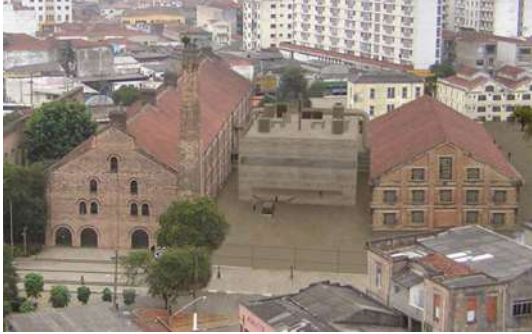
Figura 455 – Intervenção no Conjunto das Retortas. Fonte: Acervo do escritório Vainer e Paoloiello.
