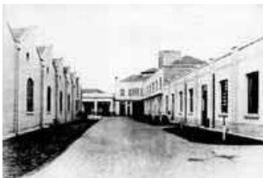
Figura 171 – Vista antiga do Complexo Argos. Fonte: Prefeitura Municipal de Jundiáí.
