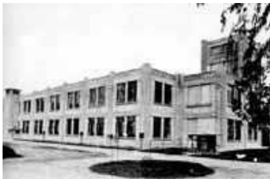
Figura 170 – Vista antiga do Complexo Argos. Fonte: Prefeitura Municipal de Jundiáí.
