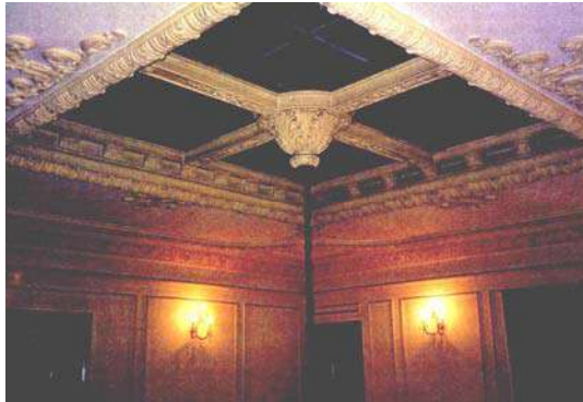
Figura 176 – Saguão central antes da intervenção. Fonte: Acervo do escritório Brasil Arquitetura.
