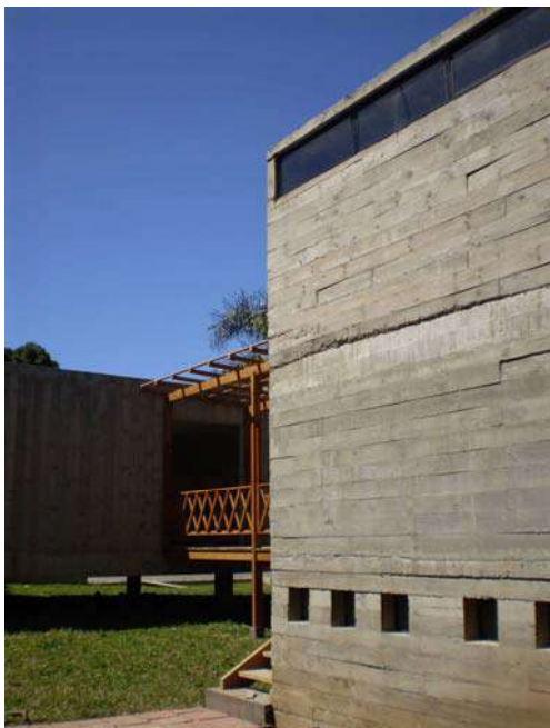
Figura 412 – Escola de Panificação ainda em obras. Foto: Patricia Viceconti Nahas.
