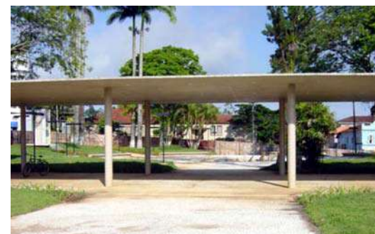
Figuras 135 e 136 – Praça dos Expedicionários, durante as obras. Fonte: Acervo do escritório Brasil Arquitetura.
