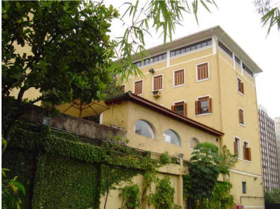
Figura 459 – Vista dos fundos do prédio, antes da intervenção. Foto: Francisco Fanucci.
