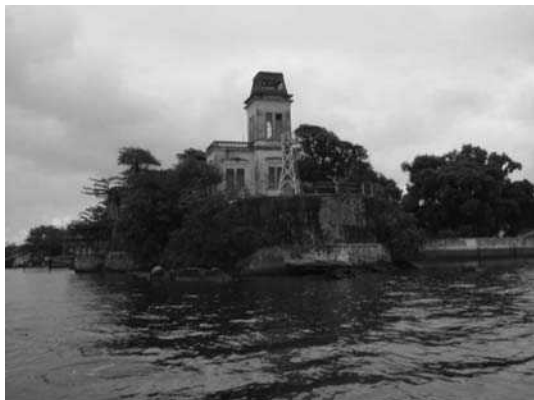
Figura 422 – Vista do Forte. Fonte: Acervo do escritório Brasil Arquitetura.
