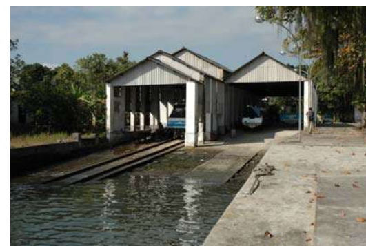
Figura 431 – Estaleiros, futura oficina de Restauro. Foto: Gustavo Ribeiro.
