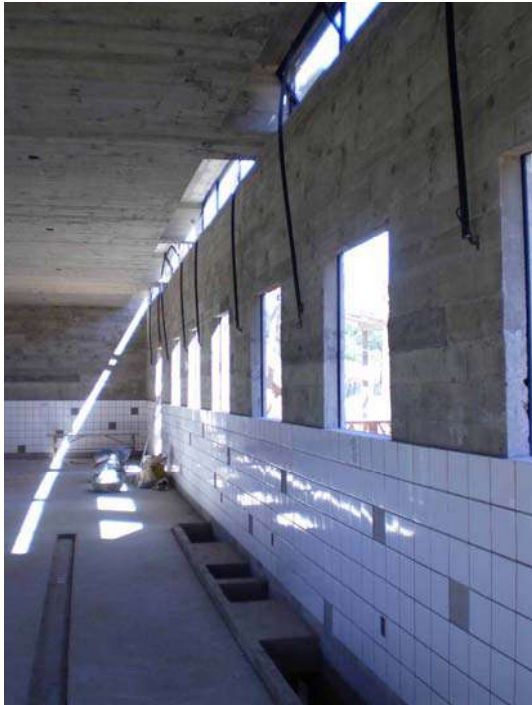
Figura 416 – Escola de Panificação, ainda em obras. Foto: Patricia Viceconti Nahas.
