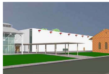
Figura 453 – Prédio novo da estação Guanabara. Fonte: Acervo do escritório Brasil Arquitetura.
