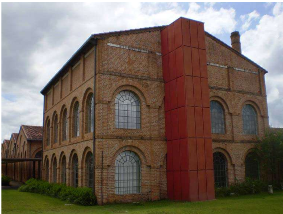
Figura 271 – Vista externa do Memorial da Imigração Japonesa – detalhe do elevador, após a intervenção. Foto: Patricia Viceconti Nahas.
