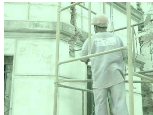
Figura 330 – Trabalho de execução das novas instalações nas fachadas. Fonte: Acervo do escritório Brasil Arquitetura.
