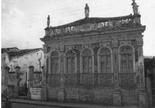
Figura 104 – Residência em Cachoeira antes a intervenção. Fonte: Acervo do escritório Brasil Arquitetura.
