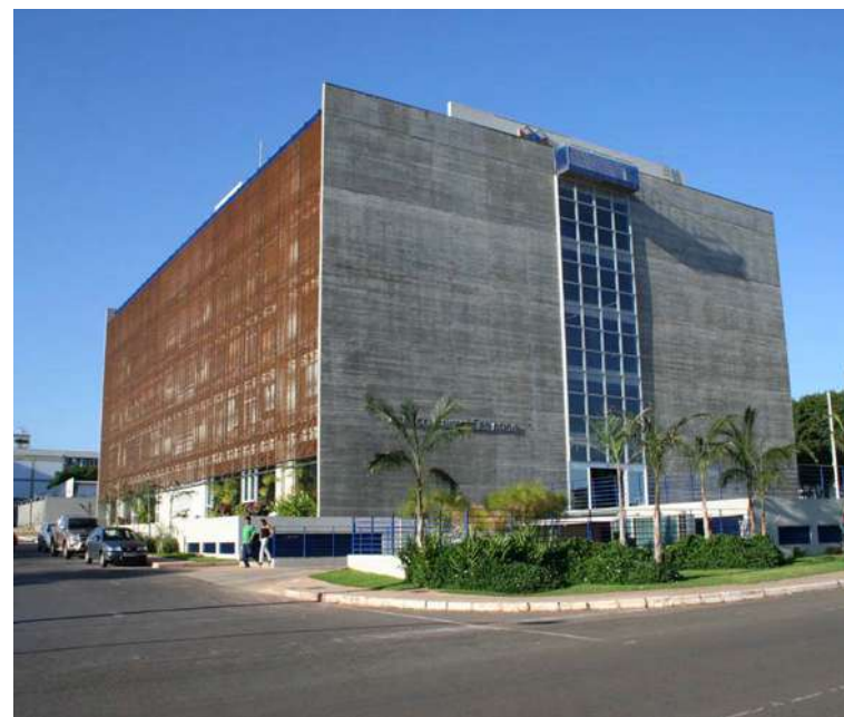
Figura 087 – Edifício Comercial Brasília. Fonte: Acervo do escritório Brasil Arquitetura.
