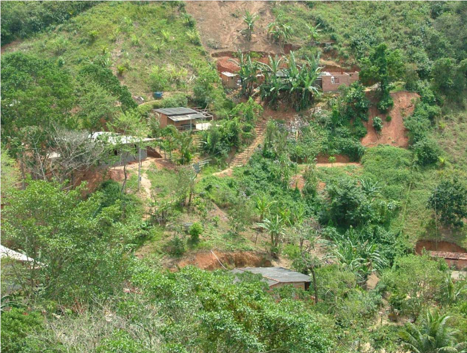
Figura 3. Área de Risco do Bairro Barra Velha. Retirada de SANTOS et al, 2005.
