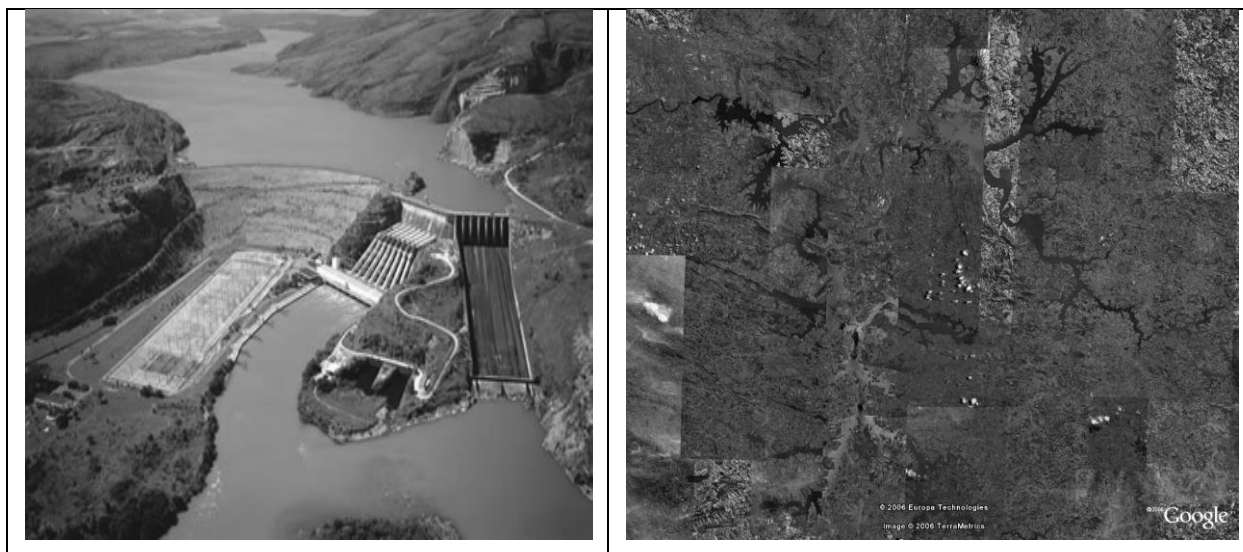
Figura B4 – Barragem da usina hidrelétrica de Furnas (esquerda) e imagem de satélite do reservatório de Furnas (direita). (Fonte: http://www.furnas.com.br/hotsites/sistema-furnas/ e Google Earth, 2006).
