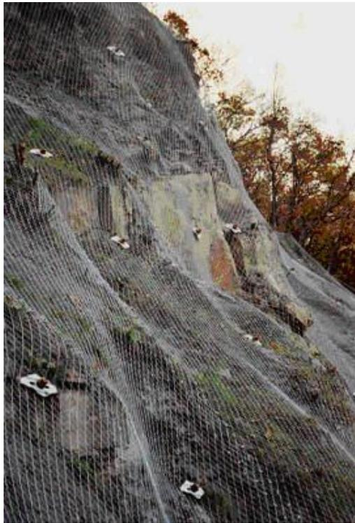
Figura 2.19 – Tela metálica (Geobrugg, 2004).
