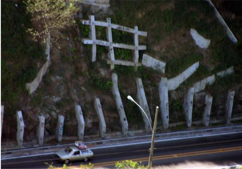
Figura 2.14 – Fixação por grelhas ancoradas e contrafortes (GeoRio, 1999).
