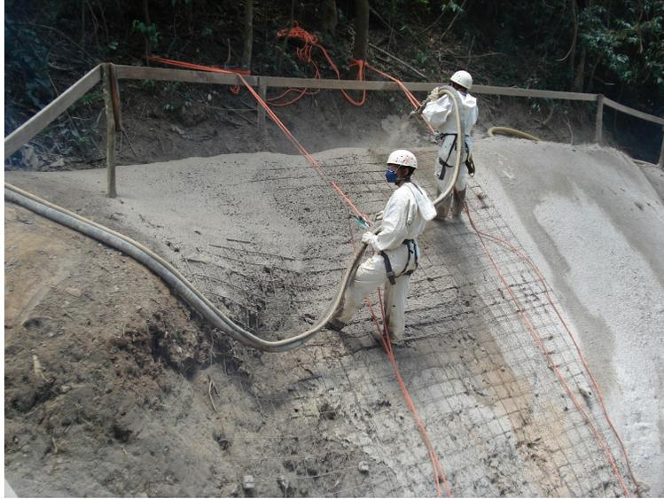
Figura 2.12 – Aplicação do concreto projetado.
