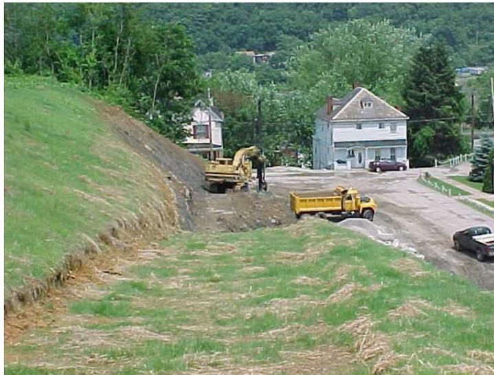
Figura 2.15 – Bermas para redução da energia dos blocos rochosos.
