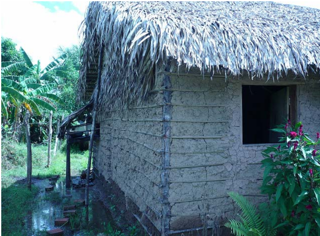
FIGURA 4.10 – Casa Alagada Cidade Nova, zona urbana do município de Rosário-MA (2008)
