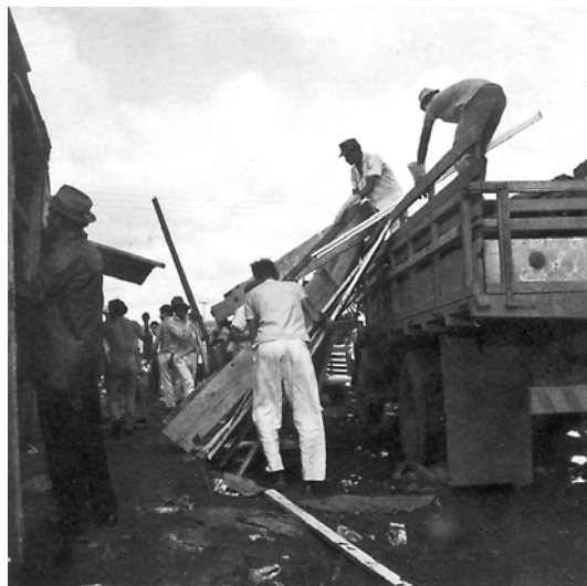
FIGURA IV Remoção de barracos na Vila Planalto
