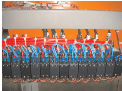
Figura 5.4: Sensores de Tensão e Corrente
