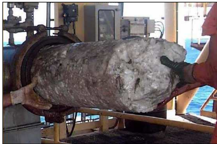
Figura 4 – Formação de hidratos no interior de tubulações.
