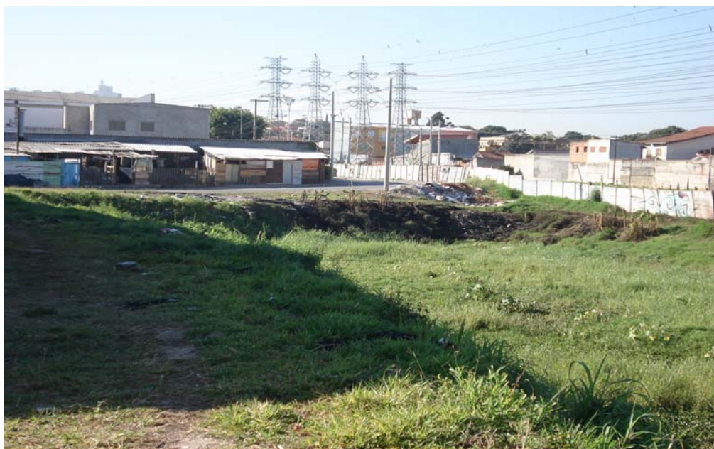
Fotografia 2 Reservatório de Controle de Cheia Urbana “Bom Pastor”. Vista do reservatório
