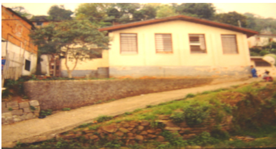
Figura 2 - Fachada do CEACRI Carrossel da Esperança, visto da rua.
