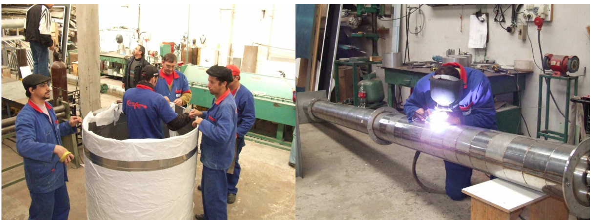
Figura 6 – Fabricação dos equipamentos da microdestilaria pela Cia do Aço
