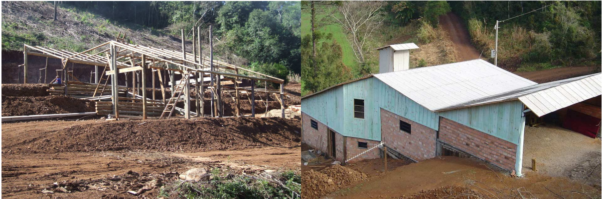
Figura 7 – Prédio em construção com postes cedidos pela Cereal e depois pronto para receber os equipamentos da microdestilaria
