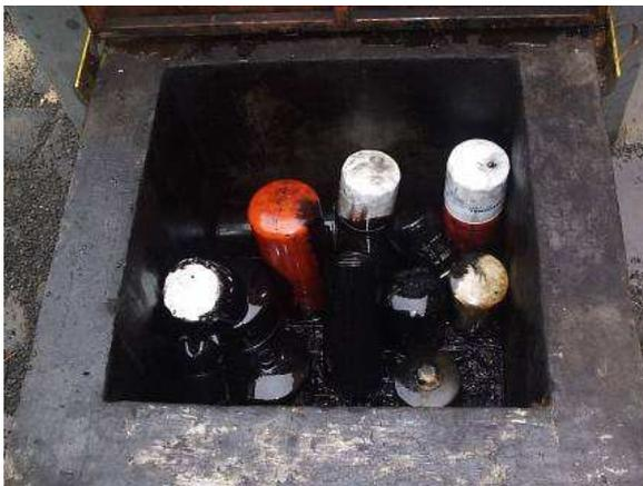
Figura 4 - Coletor de óleo dos filtros de óleo, para uma caixa de óleo de um sistema de SAO.
