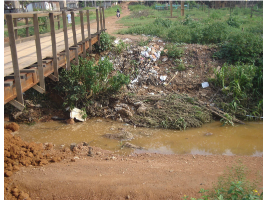
Figura 10. Igarapé dos Tanques, trecho localizado na área urbana central de Porto Velho – RO.
