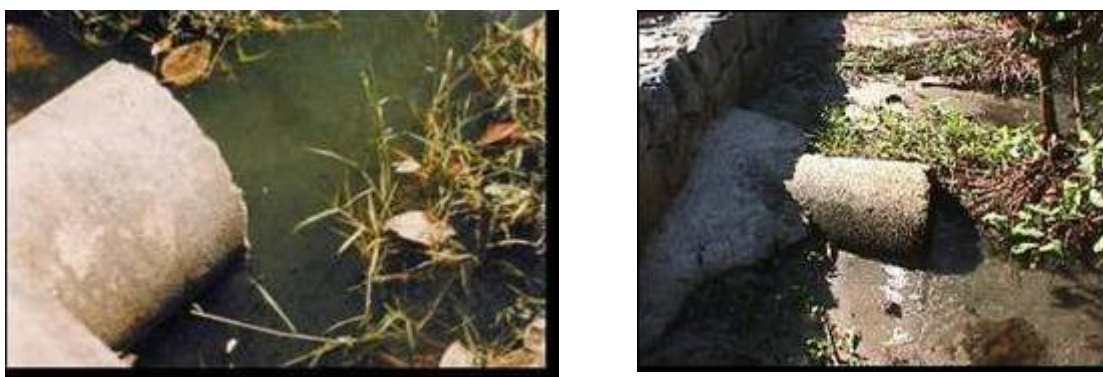
Figuras 4.7. Exemplos de lançamentos clandestinos de efluentes na Lagoa Rodrigo de Freitas (FONTE: ROSSO, 2002).
