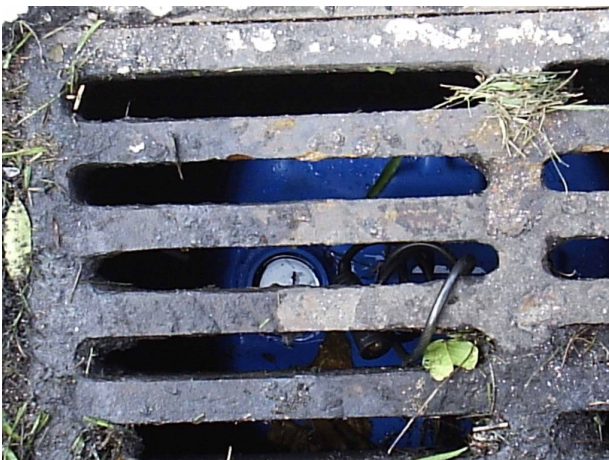
Figura 5.6 Imagem dos pontos de coletas localizadas em bueiros. Grade fechada.
