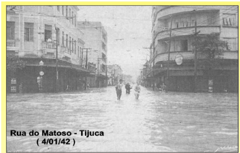
FIGURA 10 – Enchente no Bairro da Tijuca. Fonte: PLANÁGUA/SEMADS/GTZ (2001)
