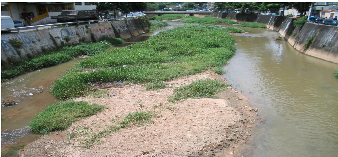
Figura 57 - Muros para controle de inundações
