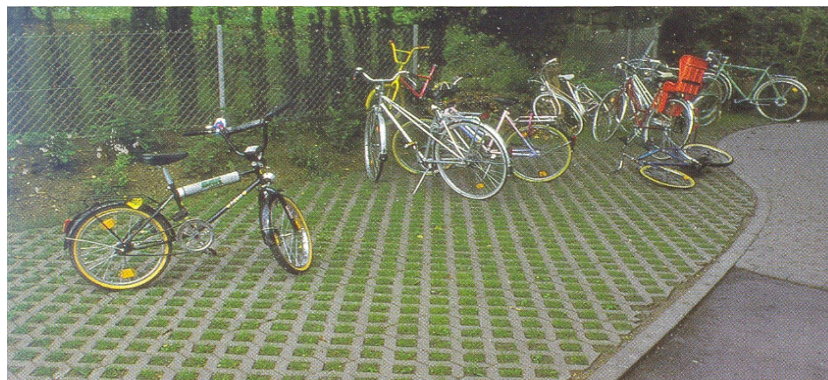
Figura 33: Pavimentação em estacionamentos
