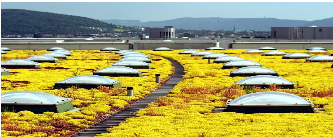
Figura 38 - Telhado do estacionamento do Aeroporto de Kloten - Zürich
