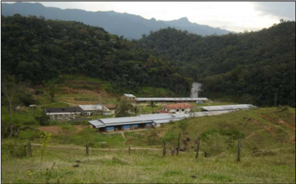
Vista panorâmica do galpão onde alguns barracos provisórios foram instalados
