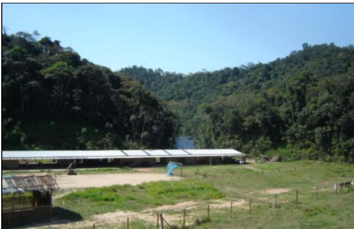
Acampamento em Tinguá: ao fundo o galpão onde as famílias foram instaladas assim que chegaram ao local.
