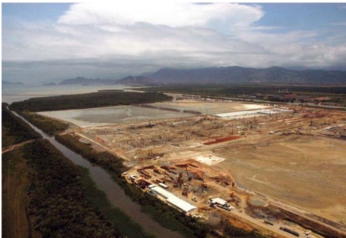
Imagem 5 - Vista panorâmica das obras do complexo siderúrgico em Santa Cruz
