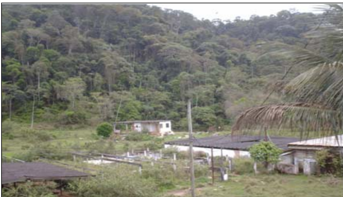
Vista ao lado esquerdo do “Casarão”: Antiga leiteria que atualmente abriga duas famílias
