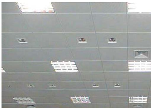
Figura A-3 – Luminárias com 4 lâmpadas em forro modulado (Refax, 2009)
