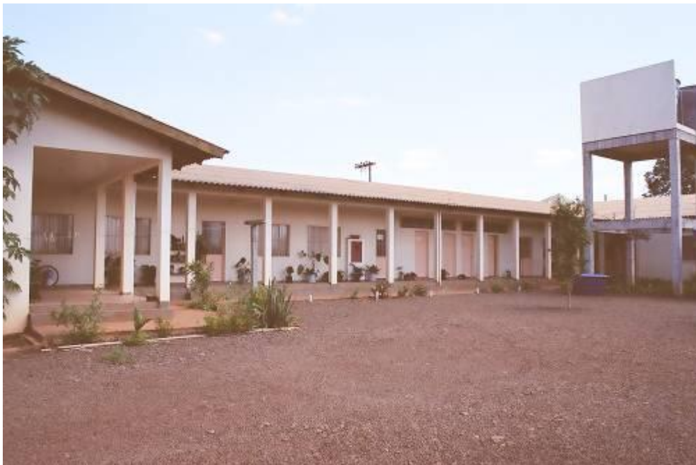
Sede do MMC, em Chapecó (SC). Fotografias feitas em fevereiro de 2008.
